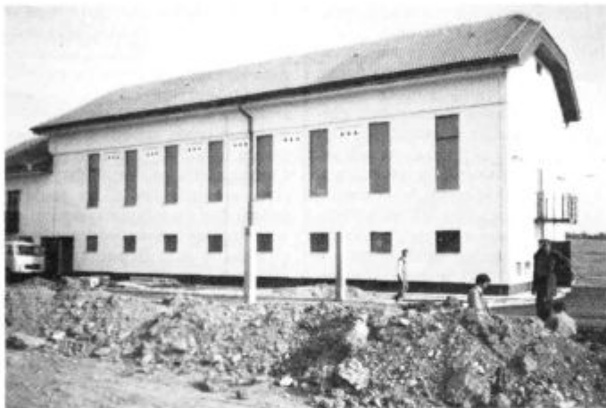
Nova trafo postaja v Sp. Porčiču. Kmalu bo nadomestila »stari Osek«.
