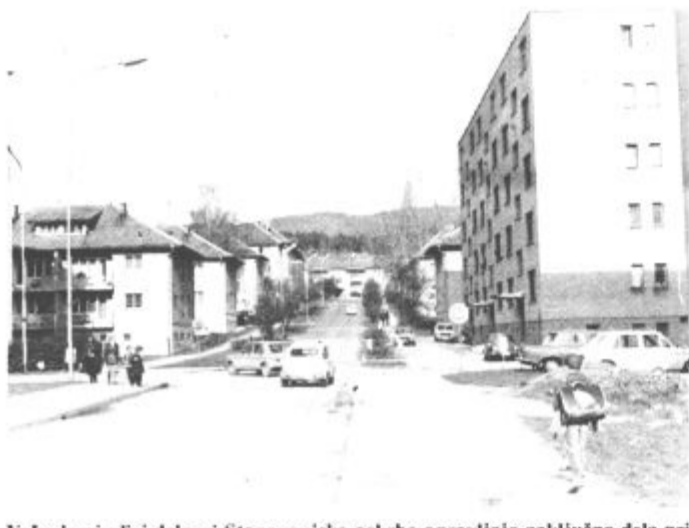
V Jenkovi ulici delavci Stanovanjske oskrbe opravljajo zaključna dela pri toplifikaciji.
