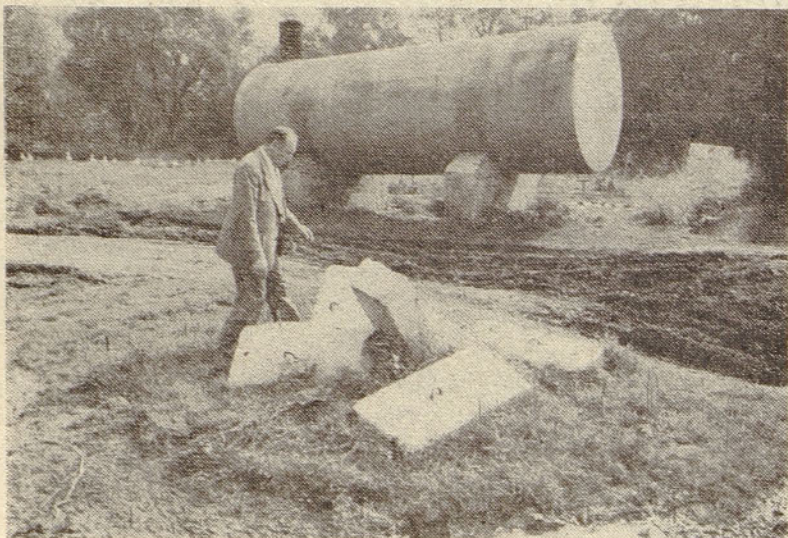
Betonska sidra za sidranje žičnic
