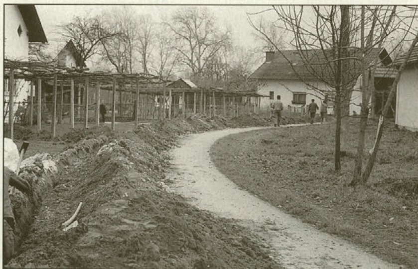
Gradnja vodovoda Šturmovci
