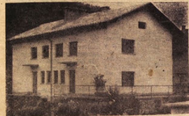
Stanovanjski blok v Jevnici
