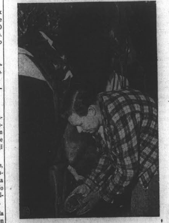
Tudi konji dobijo lažje "obuvalo." — Znani konj dirkač "Assault" prav mirno stoji, ko mu njegov kovač John Dern meri nove "čevlje." Podkve, ki mu jih bo napravil John, so iz aluminija in tehtata vsaka štiri unče, so ročno delo in vzame kovača štiri ure, da jih napravi in pribije konju na kopita. Ta dirkač je že zaslužil svojemu gospodarju $623,370 v raznih dirkah.
