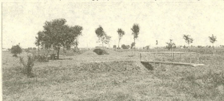
PODLOŽE: Znotraj in zunaj očiščen bunker, grajen v letih 1938/39. Je eden redkih ohranjenih v obrambni liniji izpred druge svetovne vojne ob severnem vznožju Haloz. (foto: Ivan Tušek, maj 1995)
