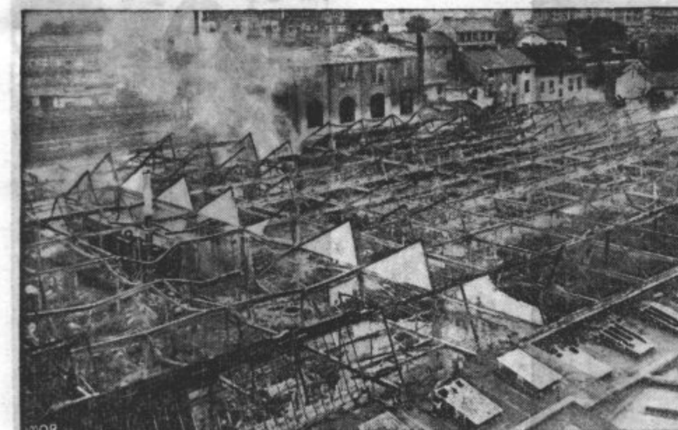
TVORNICNA TKANIN — ŽRTEV POZARA. V Novavesi pri Berlinu je nedavno sničel požar velikansko tvornico za tkanine. Ko so pogasili ogenj, je ostalo samo golo ogrodje
