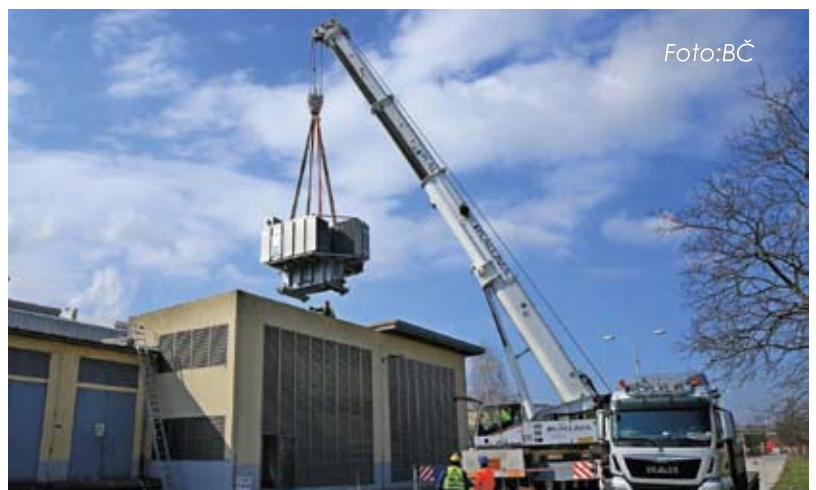
Vstavljanje novega transformatorja v trafo boks
