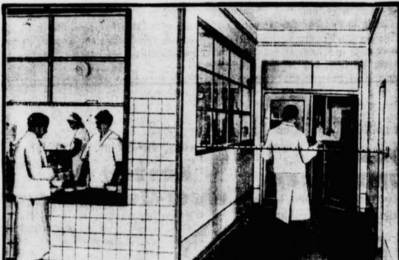
Unser Bild zeigt eine neuartige Verwendung unsichtbarer Strahlen: wenn eine Person — in unserem Falle ein Kellner — das Strahlenfeld der unsichtbaren Strahlen kreuzt, wird ein Kontakt ausgelöst, der die rechts im Hintergrund sichtbare Tür automatisch öffnet: das Feinzelmannchen ist also erfunden.
