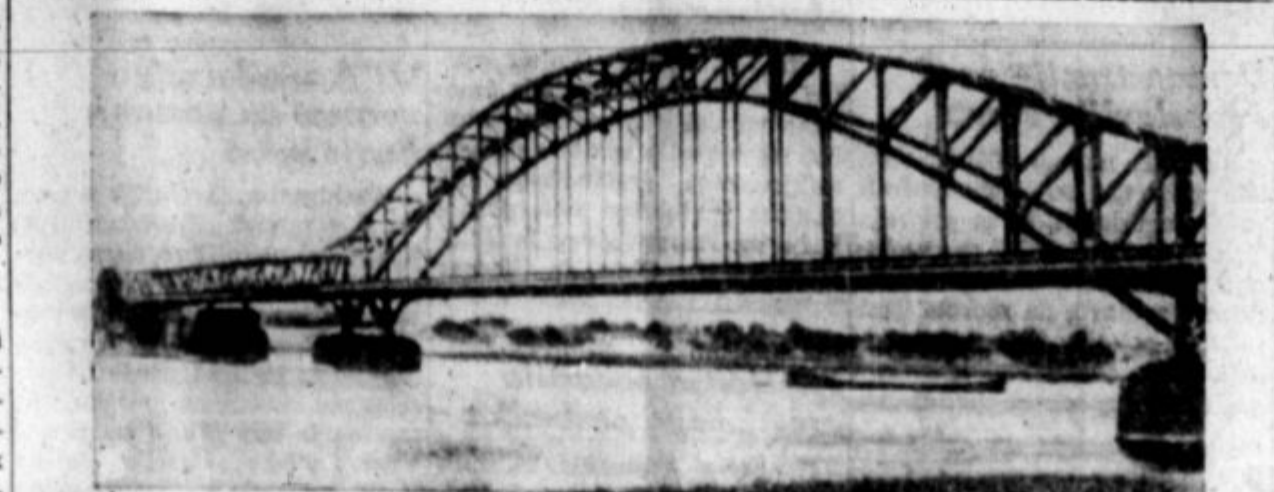
Na svojem umiku preko Rene so naciji porušili sleherni most razen tega, ki ga vidite na sliki. Nahaja se pri mostu Remagen in je padel v roke prvi ameriški armadi nepoškodovan po zaslugi nemških saboterjev, ki so prežezali vse električne žice pri razstrelivnih napravah predno je bil most spuščen v zrak. Poveljnik čete, ki je imela nalogo, da razstrelji most, je potem napravil samomor. Most se je dva tedna pozneje zrušil radi poškodb.
