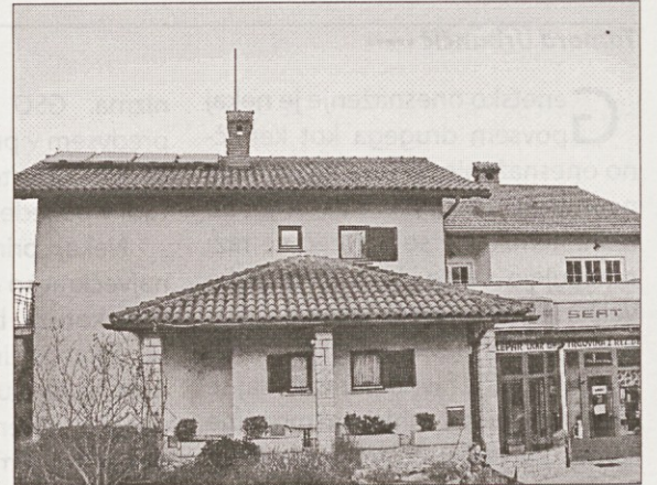
Martinčič d.o.o.-na strehi nameščeni 4. sprejemniki sončne energije, v kotlovnici 500 l boiler.
