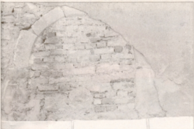
Romansko okno, dominikanska cerkev, južna ladijska stena, vidno z notranjega dvorišča križnega hodnika nad streho severnega trakta; foto: P. Vernik
