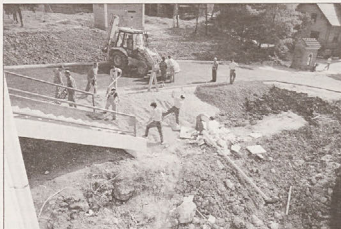
Izkop pred Žagarjevo kapelo je zvečer že prekril asfalt
