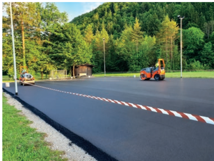
Obnova igrišča v Iški vasi
