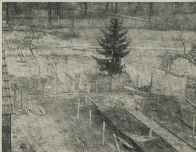
Pričeli smo z gradnjo naših delavnic
