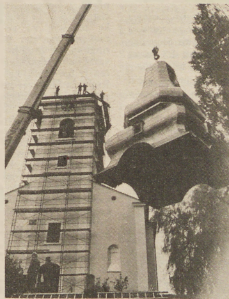
V petek so s Pranglovim dvigalom dvignili novo streho zvonika, v nedeljo pa še zadnje nastavke in križ. FOTO: JURE ZAUNEKER
