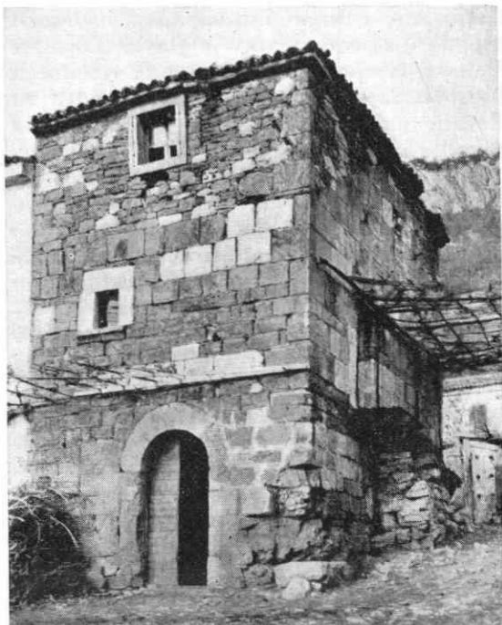
Sl. 5. Ta hiša v Črnem kalu, ki je nad vrati datirana 1489, je nastala že, ko je bila vas beneška in je doživela Maksimiljanove vojne. Gornji del, zgrajen iz manjših kamnov, je nadzidan kasneje. Prejšnji zatrep na desni se dobro razloči
