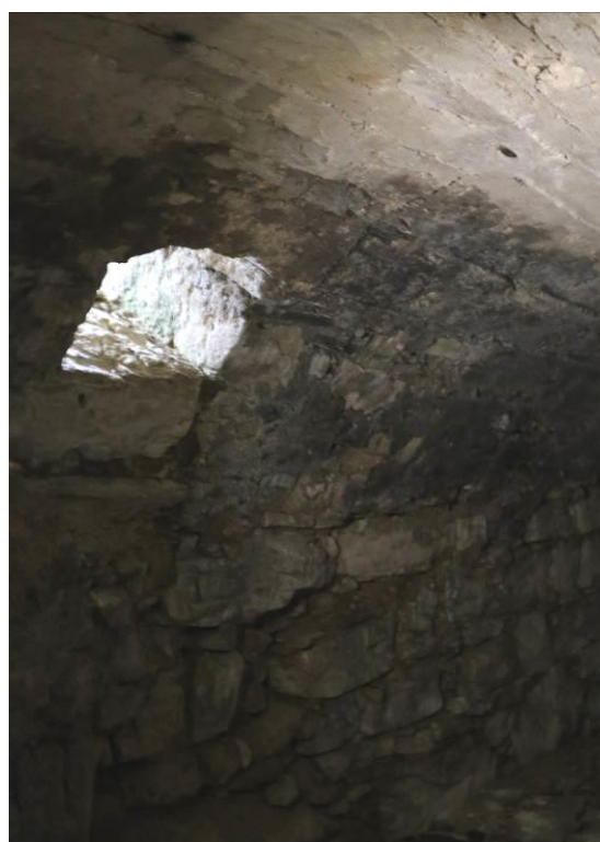
Slika 125: Najbolj zanimiv je ozek kletni prostor vzdolž celotnega shrambnega dela. Polkrožno obokan, s preходом do kuhinje na koncu in z odprtino za vsipavanje krompirja z zgornje strani hiše. Ob odprtini poteka rob, ki kaže, da je bila klet nekoč podaljšana.
