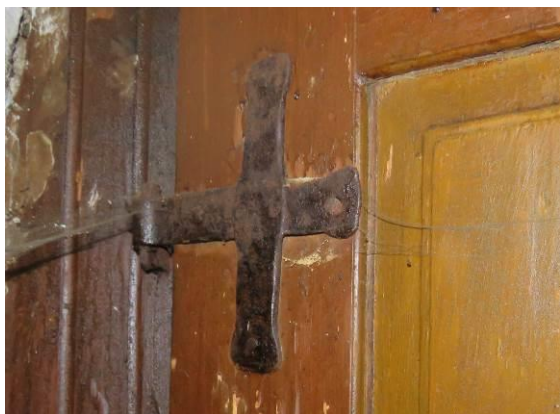
Slika 92: Staro okovje vrat iz podstrehe. Kovaški izdelki v tukajšnjih stavbah so redki in skromni.
