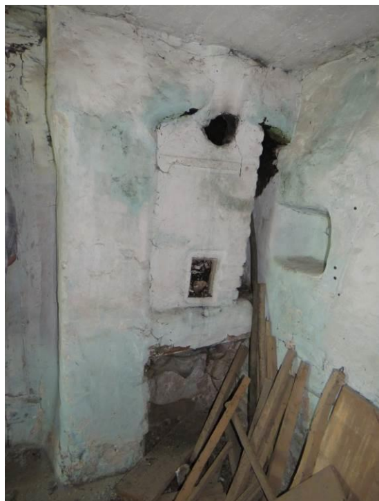
Slika 97: Zazidano ognjišče pred ustjem krušne peči v Janeščevi bajti. Nad njim je bil na stropu nekoč velb. Desno ob njem je odprtina za odlaganje soli, kresila ipd.
