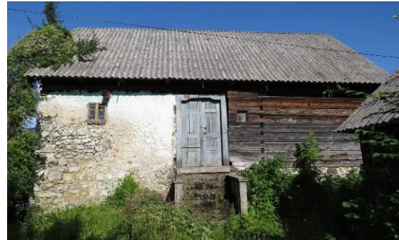
Slika 226: Sprednja stran hiše na Podgori, levi del zidan, desni del grajen iz štiristransko obtesanih brun.
