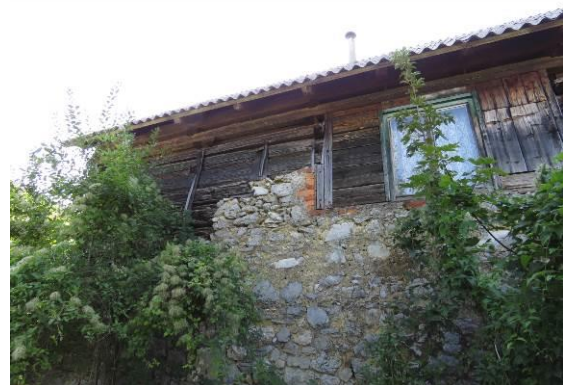
Slika 228: Zadnja stena, izdelana enako kot v Mirtovičih: levo in desno lesena stena, v sredini zidan del kamnite stene ob ognjišču. Tam je bilo kasneje predrto okno.
