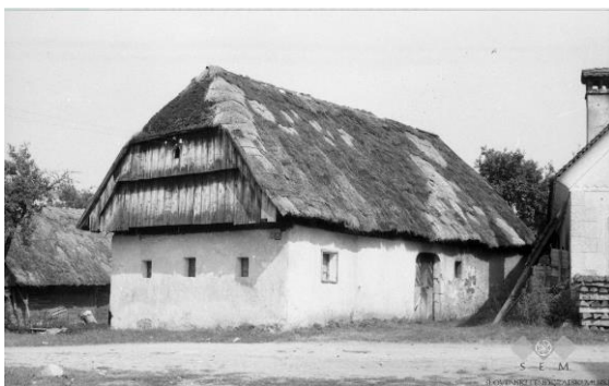
Slika 64: Stara hiša z gostilno pri Jagru, slikana v 1960-ih, enotraktna stavba. Na katastru je označena s št. 3 (vir: fototeka SEM).
