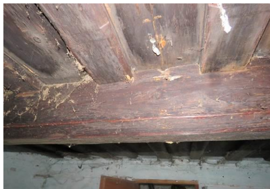
Slika 99: Lesen strop iz plohov, s preprosto, pod 45 stopinjami pobranimi robovi, enako je obdelan tudi stropnik.
