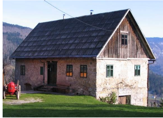
Slika 179: Ena od dveh najstarejših hiš v zgornjih Tropetih, hiša št. 11. Levo od vrat malo vežno okence, za pretok zraka skozi črno kuhinjo.
