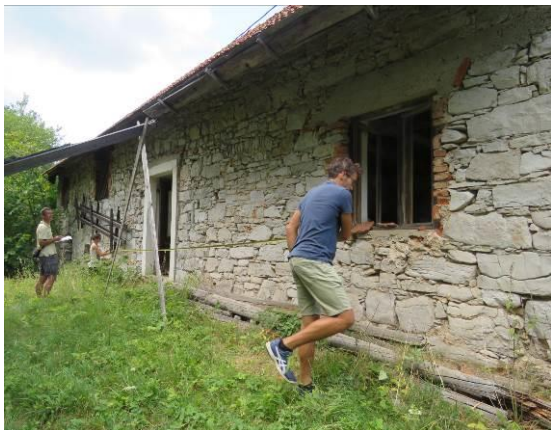
Slika 119: Gradbena in arhitekturna analiza hiše ni mogoča brez dokaj natančnih meritev stavbe.
