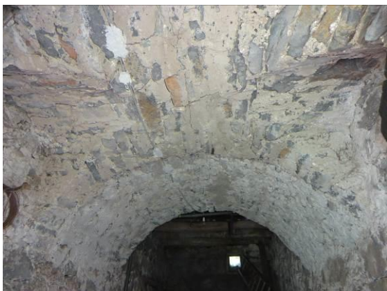
Slika 335: Zadaj polkrožni obok, ki je bil prvotno le pod ognjiščem, spredaj križni obok, kasnejše gradnje v 19. stoletju.
