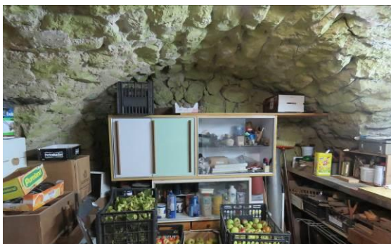
Slika 307: Kamniti križni oboki so zloženi iz skrbno izbranega kamnja in še vedno neometani, kar jim daje posebno pričevalnost.
