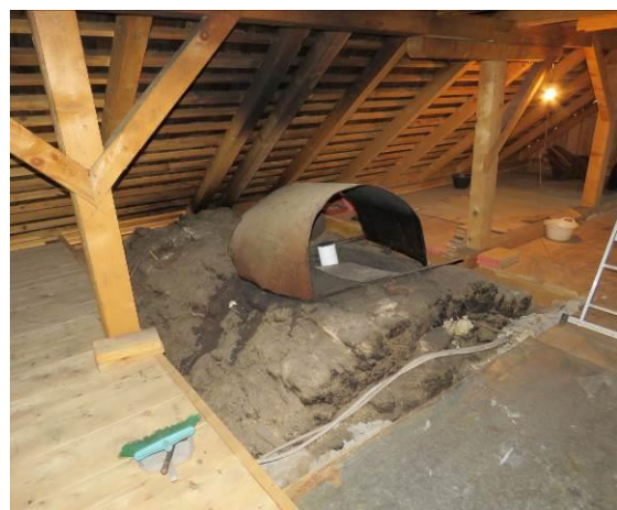
Slika 372: Kuhinjski velb na podstrehi. Hiša je brez dimnika, odprtina za dim je zaradi varnosti pokrita s pločevino.
