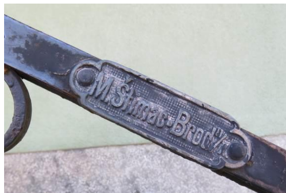
Slika 394: Lita oznaka izdelovalca ograje M.Štimac, Brod n/K.. Spodaj detajl ograje iz industrijsko predizdelanih elementov.
