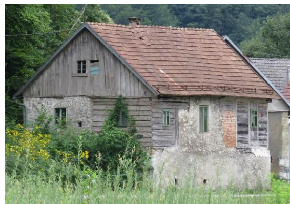
Slika 274: Hiša ob cesti s sredinsko steno, ob kateri je v sredini nekdanje odprto ognjišče. Levi leseni del je še iz tesanih brun, desni že iz žagane predalčne konstrukcije.
