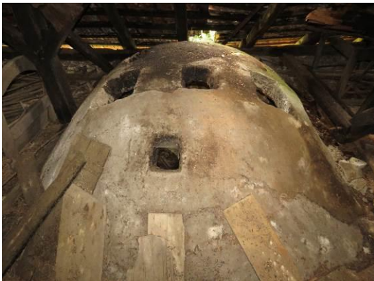
Slika 297: Kupola na podstrehi za zbiranje dima nad nekdanjim ognjiščem kuhinje, z odprtini za odvod dima.
