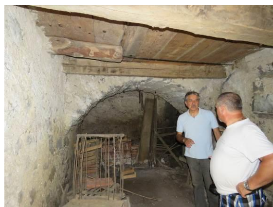
Slika 339: Tako so verjetno izgledale prvotne kleti pred obokanjem; obok pod ognjiščem, ostalo lesen strop proti stanovanski etaži.
