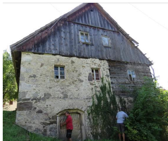
Slika 153: Pogled na vhod Bajtarjeve hiše z zazidanimi starejšimi okni in spodaj na Z del hiše, ki se od 1843. leta ni spreminjal. Spodaj je vhod v klet.
