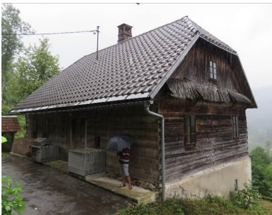
Slika 148: Lesena hiša na spodnjem delu pod Groharji. Sestavljena iz štiristransko žaganih brun.
