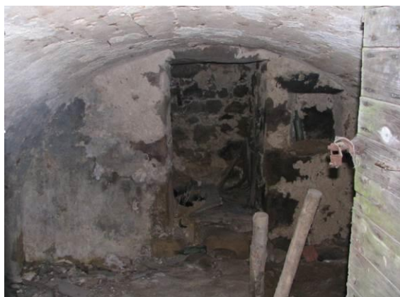
Slika 327: Polkrožno obokana klet Janezovih s prehodom navzgor proti kuhinji.
