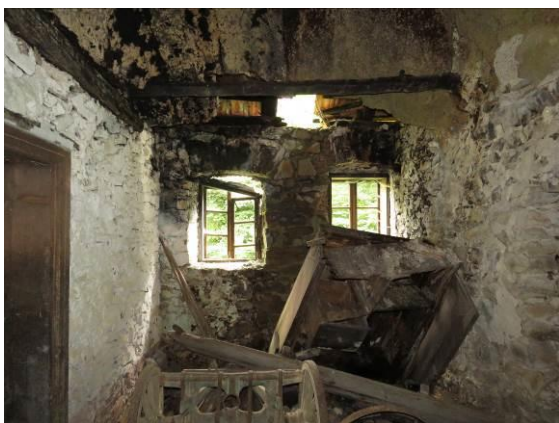
Slika 288: Pod oknoma je v zadnjem delu prostora nekoč na polkrožnem velbu kleti stalo ognjišče višine 30-40 cm, ki je razdrto.
