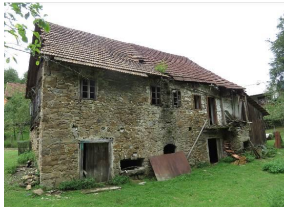
Slika 284: Zadnji del hiše z vhodi v kleti in štale. Stene so zidane, srednji dve okni nad ločno obokanim kletnim vhodom sta kuhinjski. Skoraj preko celotne strani je nekoč potekal gank. Desno kamniti del s straniščem.
