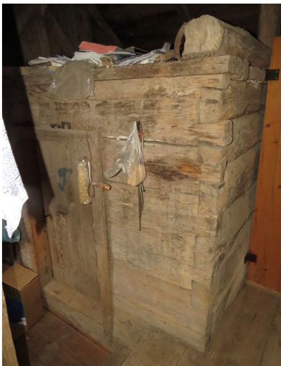
Slika 269: Kašča je tudi tu stavba v stavbi, grajena iz tesanih brun, spojenih na lastovičji rep.
