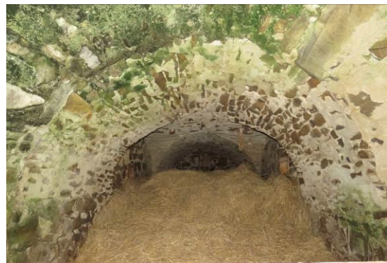
Slika 301: Polkrožno obokan del pod kuhinjo in vežo je edini obokan del kleti. Vsi ostali imajo lesen strop. Pod kuhinjo je obok polkrožen, pod vežo križen.
