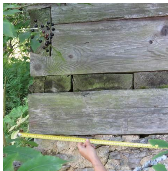
Slika 230: Mala lesena kašča z vrezano letnico 1818 ob vratih. Spodaj spodnji del njene konstrukcije, grajena je iz žaganih plohov debeline 10 cm.
