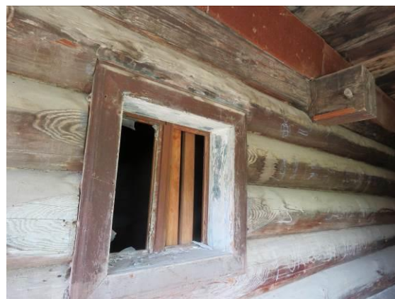
Slika 102: Leseno ostenje bajte z majhnimi kvadratnimi okni pribl. 45x45 cm, desno se vidi zunanji del stropnika, pogled iz vhodnega vogala dostopnega ganka.
