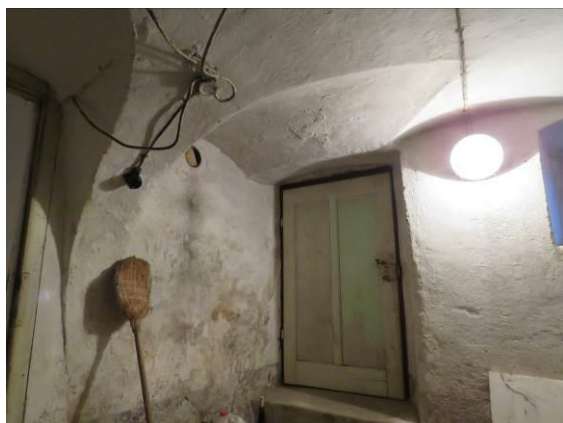
Slika 133: Pogled iz križno obokane kleti na vhodna vrata iz dvorišča. Nivo kleti je nekaj stopnic pod dvoriščem.
