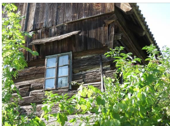
Slika 229: Na vzvodni steni hiše so lepo vidne odprtine manjših kvadratnih okenc levo in desno od sedanjega. Postavljena so bila precej nižje od novejših.
