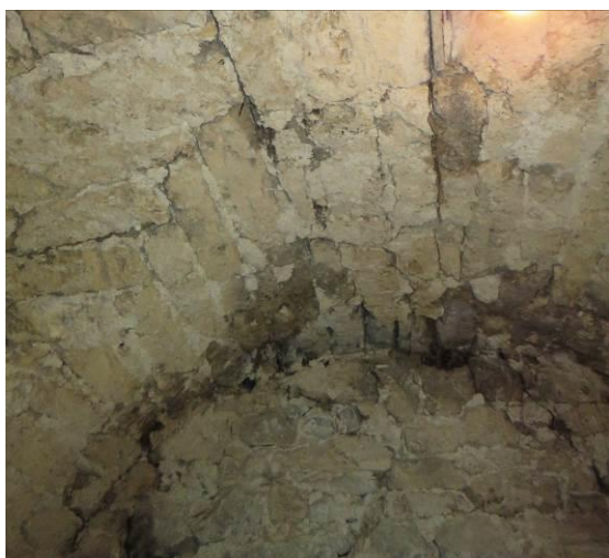
Slika 368: Oboki kašče so grajeni iz pravilno obdelanih kamnitih kvadrov.
