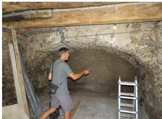
Slika 334: Obok pod nekdanjim ognjiščem v hiši iz 1832. leta, ki je bilo opuščeno do konca 19. stoletja.
