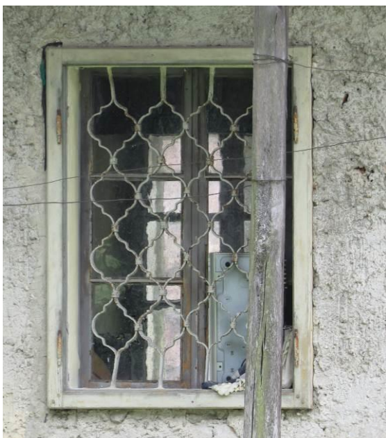
Slika 318: Gajtra na oknu v prvem nadstropju hiše iz zgornje fotografije so iz prve polovice 19. stoletja. Verjetno je okno služilo za dovod zraka za ognjišče črne kuhinje in boljši pretok zraka – dima proti podstrešju.
