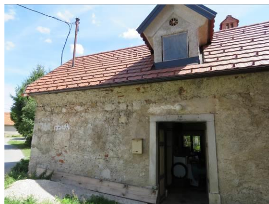
Slika 89: Češjenčeva bajta s klesanim portalom iz 1904 in levo vidno zazidano (eno ali dve) manjšo okensko odprtino.
