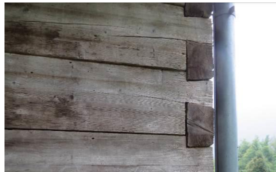
Slika 149: Vogalni stiki so enostaven lastavičji rep, ki je dovoljeval kasnejše poletvanje in omet za zaščito konstrukcije pred dežjem.
