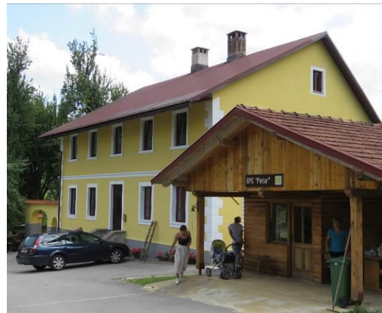
Slika 184: Hiša Pintarjevih je dobila novo nadstropje z dvigom sprednjega dela strehe že pred drugo vojno. Prej je imela streho s čopom in je bila pritlična.
