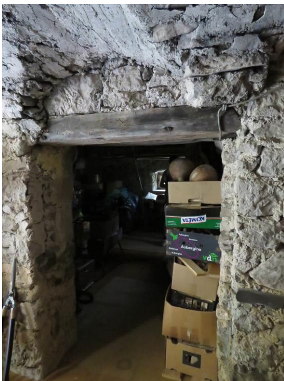
Slika 308: Za razliko od prvotno načrtovanih odprtin so naknadno izvedene vedno stvar kompromisa, kar vidimo tudi iz te lesene preklade.
