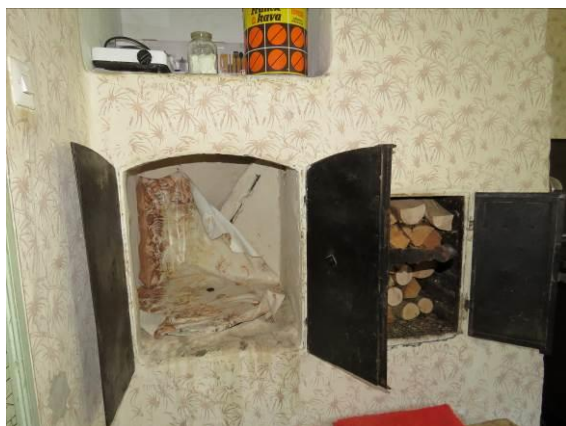
Slika 338: Večina hiš ima poleg kurišča za krušno peč v kuhinji še zaprt kotel za kuho živalim.
