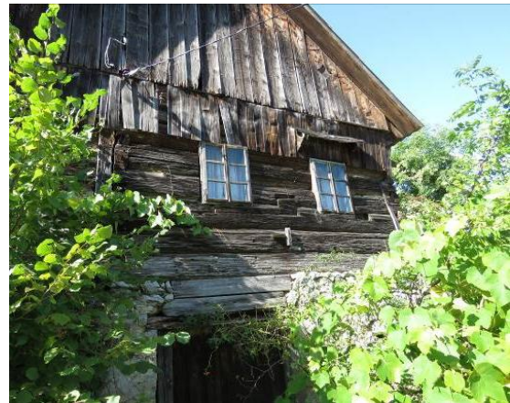
Slika 227: Stran hiše proti Požarju. Iz brun je razvidno, da je desni del z dvema oknom ločen od levega dela.
