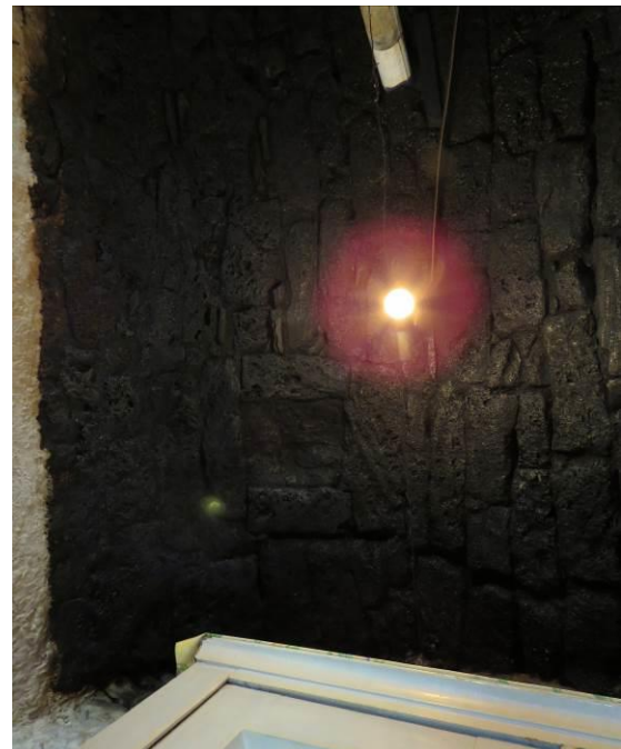
Slika 366: Velb iz lehnjaka nad ognjiščem se razteza od loka proti sprednjemu delu veže do zadnje stene. Levo je vidna zazidana odprtina za dim.
