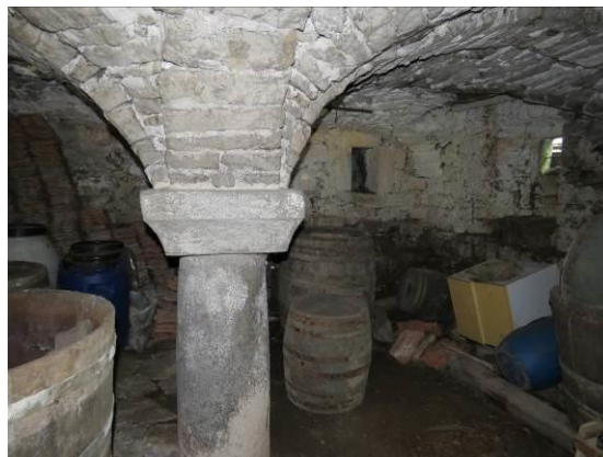
Slika 352: Kamnit stebler in oboki v kleti stare hiše poleg Šimakove.
