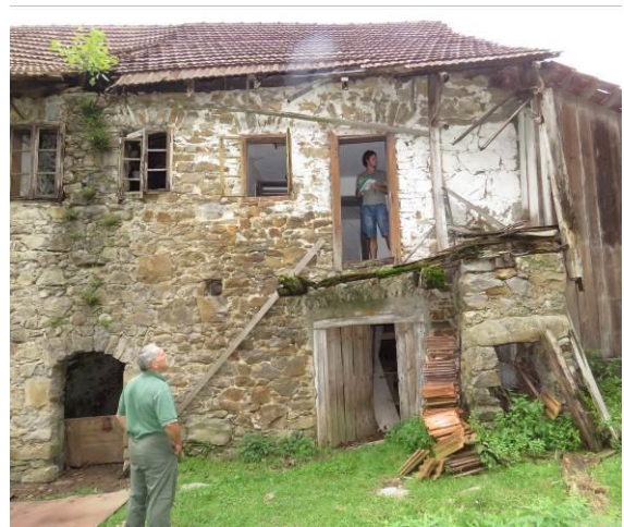
Slika 299: Pogled na zadnjo desno stran s preходом na nekdanji gank. Desno zidani del s straniščno jamo z veliko kamnito preklado.
