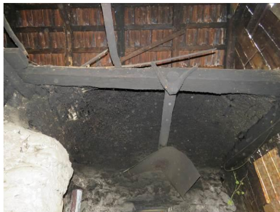
Slika 336: Velb nad ognjiščem (levo) v bajti pri Zdolenjskih je narejen iz pletenega šibja, ometanega z glino. Pod njim je palica za sušenje mesa. Sprednji del veže je odprt v ostrešje. Bajte so se le malo razlikovale.
