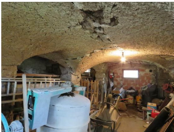
Slika 364: Oboki v razširjenem prostoru čez ostale \frac{3}{4} kletne etaže, ki je služil štali s prehodom za voz. Vse skupaj stoji na zidanem stebru (za mešalcem).
