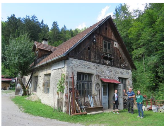
Slika 208: Stavba Urhove kovačije v Čabru je taka, kot je bila zgrajena 1936. leta.
