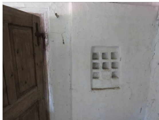
Slika 292: Ogrevanju hišne kamre je služila stena proti krušni peči in vzdani lonci pečnic, ki so povečali njeno površino.
