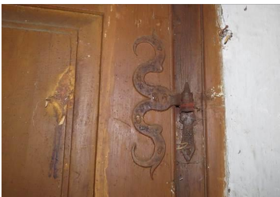
Slika 158: Okovi vrat iz 1843. leta, njihova oblika je bolj nebaročna kot desetletje kasneje.
