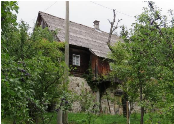
Slika 151: Bajtarjeva vrhhlevna hiša, z gankom na spodnji strani, na katerem je tudi stranišče. Obrnjena je prečno na breg.
