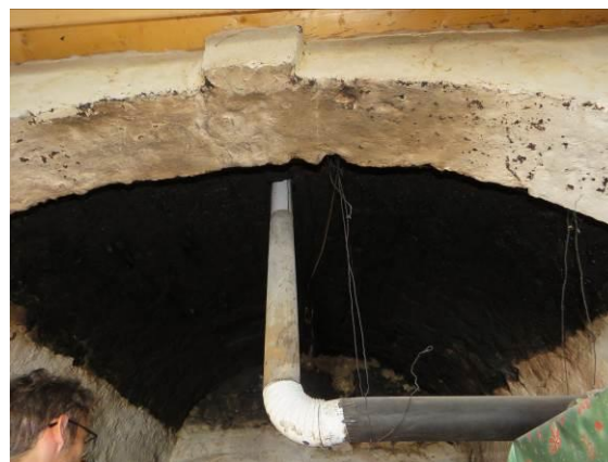
Slika 371: Hiša po obnovi ostaja brez dimnika, štedilniška cev gre skozi velb nad nekdanjim ognjiščem in na podstreho. Spredaj lok, ki zapira vežo proti ognjiščni kuhinji.
