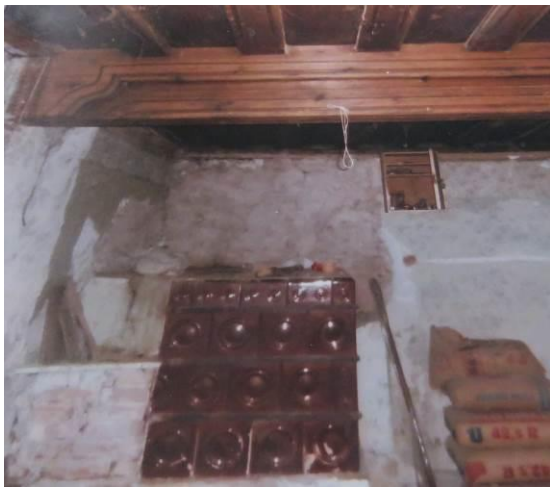
Slika 70: Fotografija notranjosti sosednje - Pavečave hiše, ki je podrta. Kot s krušno pečjo in zapečkom, bogato profiliranim stropnim tramom in lesenim stropom, verjetno vsaj iz prve polovice 19. stoletja (arhiv J. Ovsec).
