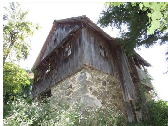
Slika 234: Zanimiva hiša malega kmeta v Požarju, postavljena močno v breg. Vhod v stanovanjsko etažo je iz brega.
