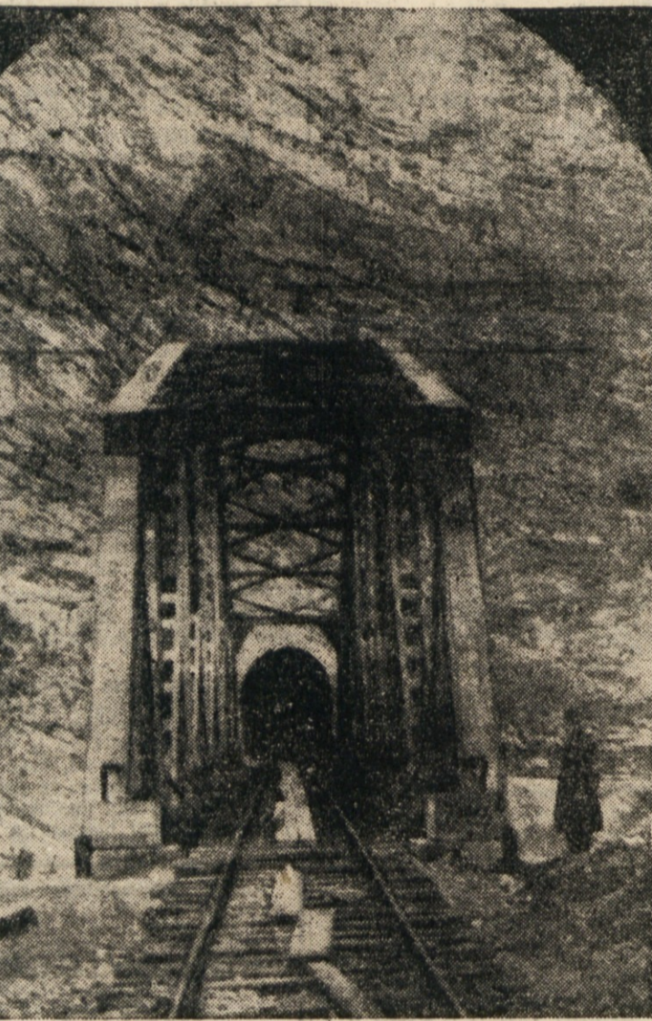
Most «Bivač» čez Uno med dvema predoroma med postajo Ripač in Loskun. — Unška proga ima nad 40 večjih mostov in viaduktov. Trije veliki mostovi čez Uno, Krko in Ostrovico so največji objekti na progi. 36 predorov v dolžini čez 12 km tvorijo delež proge. Zgrajeno je bilo 16 modernih postaj z več kot 300 postopji.
