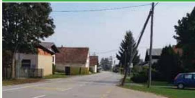
Obnova cest po celotni občini
