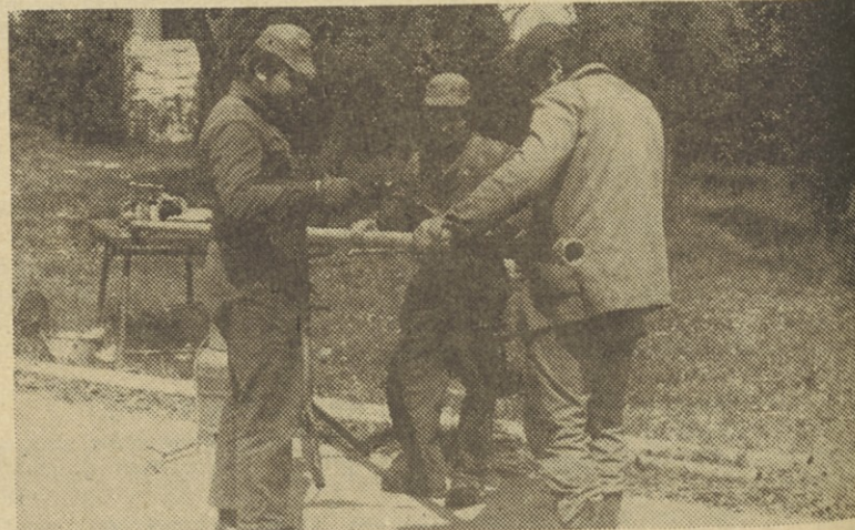
Priprava cevi za zunanji razvod
