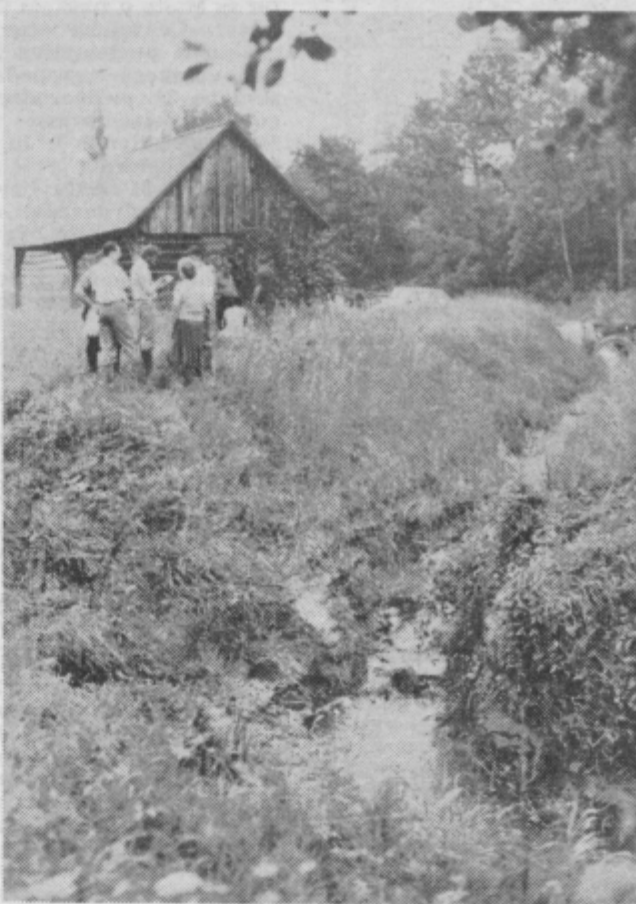
Kanaliziran Kandolov potok za potrebe nove deponije Cinkarne Celje. V ozadju predstavniki občinskega inšpektorata, Zavoda za ribištvo SRS, RD Voglajna in Cinkarne.
