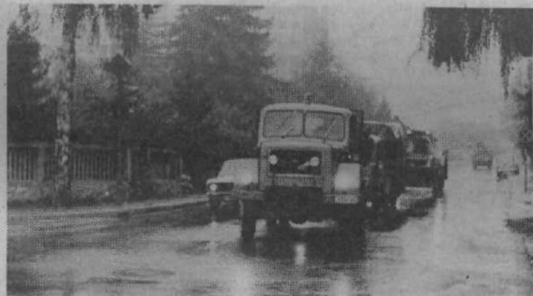
Ekipa za očiščenje ruševin Komunalnega podjetja Ljubljana – TOZD Komunalne gradnje je s svojo posebno opremo in vozili med prvimi prihitala do porušenihih stavbi
