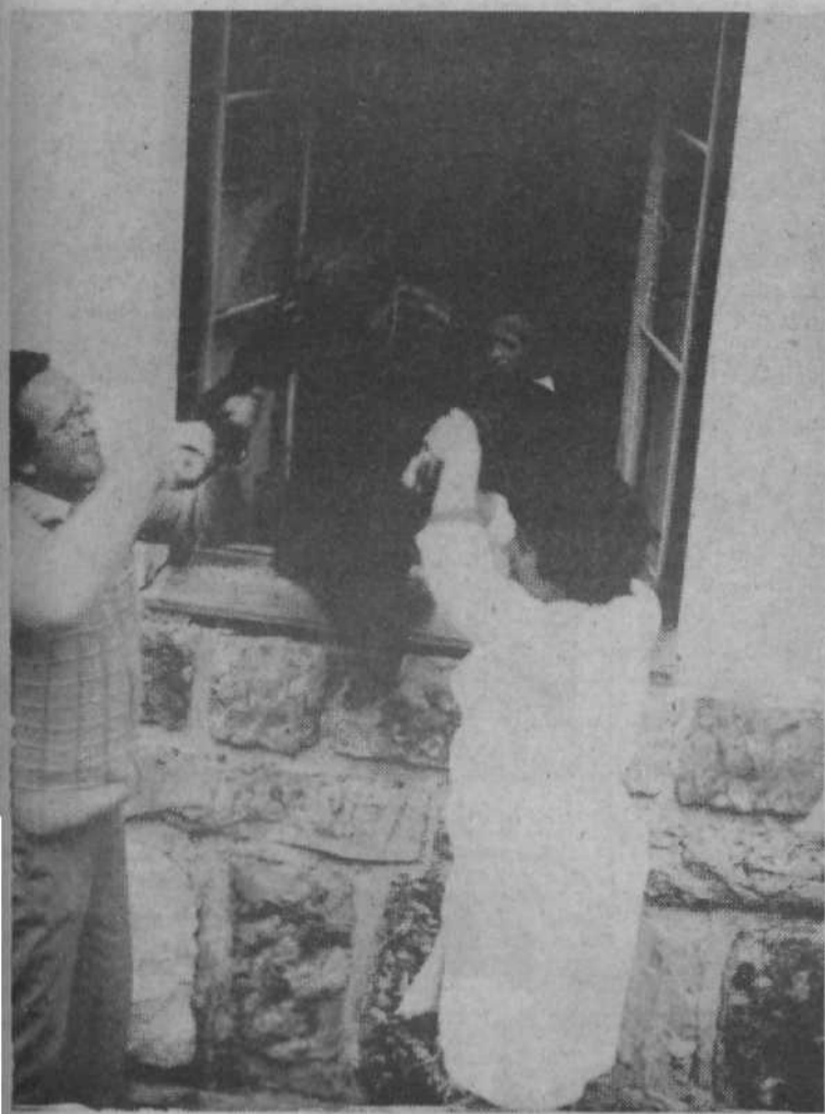
Dej šole na Črnem vrhu se je zrušila že v prvem potresnem sunku. Poškodovano je bilo tudi stopnišče. Zato so učitelji in drugo šolsko osebje, ki ni bilo ranjeno, pomagali učencem iz zgradbe kar skozi okno. Za tiste, ki so ostali v prvem nadstropju pa so poskrbeli gasilci in pripadniki civilne zaščite, ki so medtem že prihitali na pomoč. Marsikateremu maličku je močneje utripalo srce ob spustu po lestvi, vendar se je v varnih rokah reševalcev vse srečno končalo.
