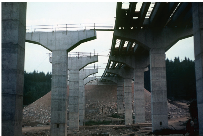
Slika 9. Gradnja podpornih stebrov viadukta Ravbarkomanda. (Vir: Fotoarhiv DARS).
