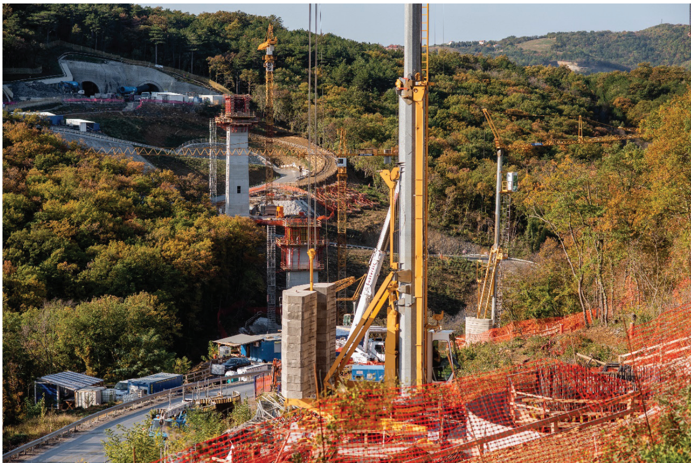
Slika 12. Gradnja viadukta Vinjan.
