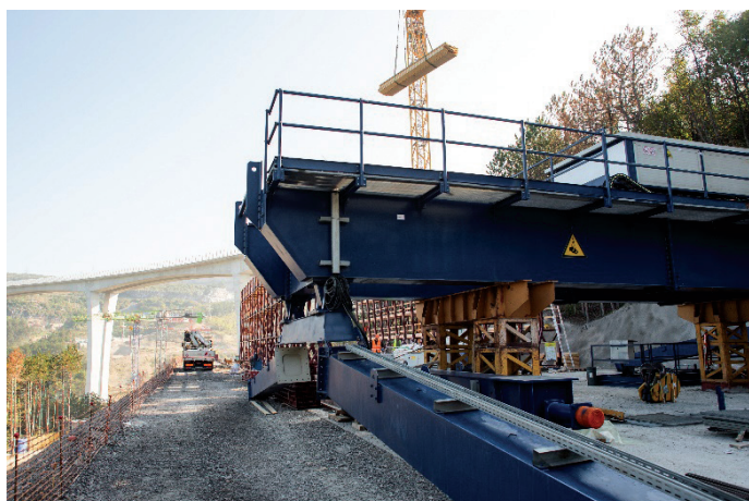
Slika 10. Delavnica pri viaduktu Gabrovica.
