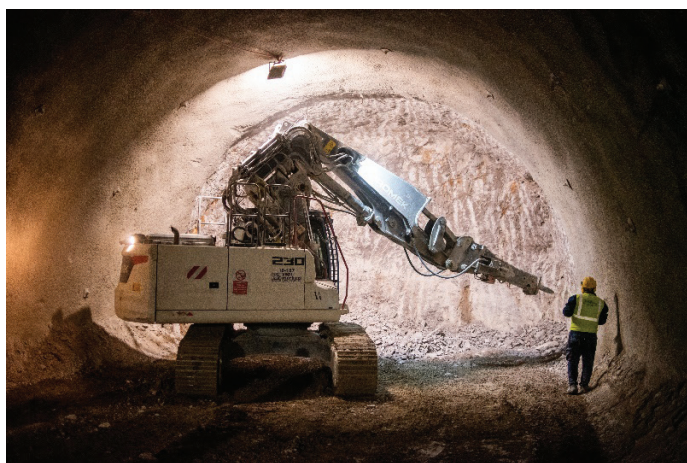
Slika 3. Izkopna dela v predoru Beka (T2).
