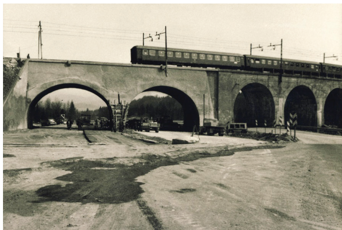
Slika 3. Začasni obvoz pod Štampetovim mostom na odseku med Vrhniko in Logatcem. (Vir: Fotoarhiv Gregorja Ficka).
