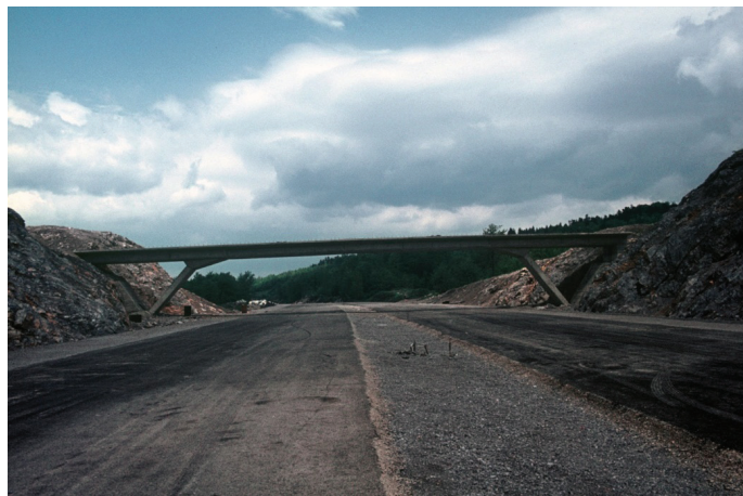
Slika 6. Nadvoz na odseku avtoceste med Vrhniko in Logatcem v smeri proti Postojni. (Vir: Fotoarhiv DARS).
