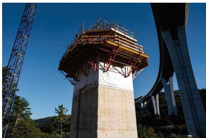
Slika 11. Gradnja stebrov pri viaduktu Gabrovica.
