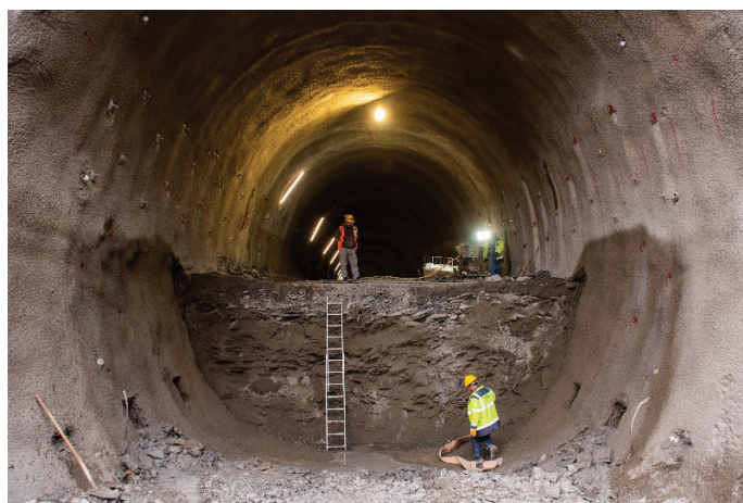
Slika 4. Izkop in podpiranje stopnice s talnim obokom v predoru Beka (T2).
