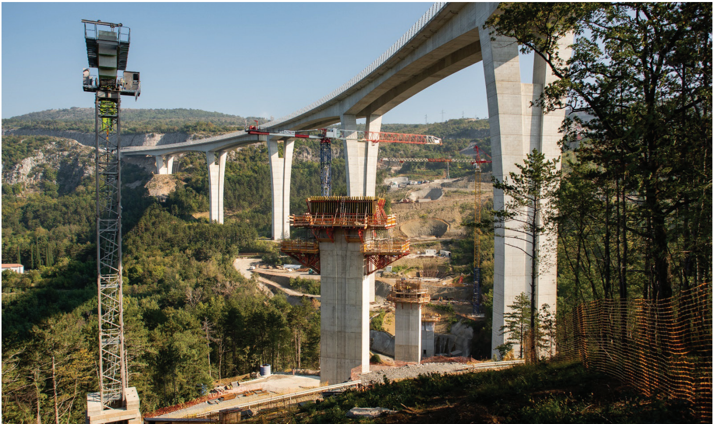
Slika 1. Gradnja viadukta Gabrovica pod avtocestnim viaduktom Črni Kal.
