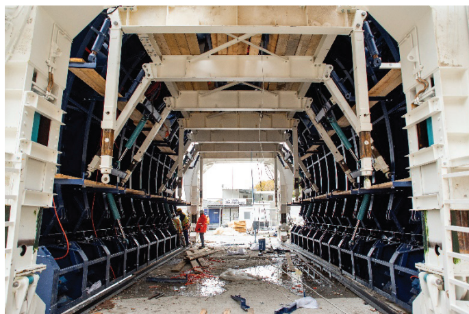
Slika 8. Opažni voz od znotraj.
