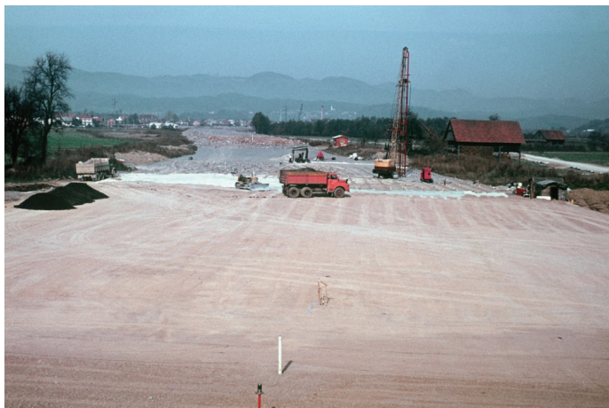
Slika 2. Gradnja voziščne konstrukcije na odseku med Vrhniko in Logatcem v smeri proti Ljubljani. (Vir: Fotoarhiv DARS).
