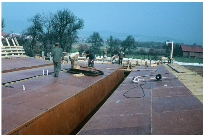
Slika 4. Gradnja viadukta Verd na odseku med Vrhniko in Logatcem. Izdelava pomičnega opaža prednapete monolitne prekladne konstrukcije. (Vir: Fotoarhiv DARS).
