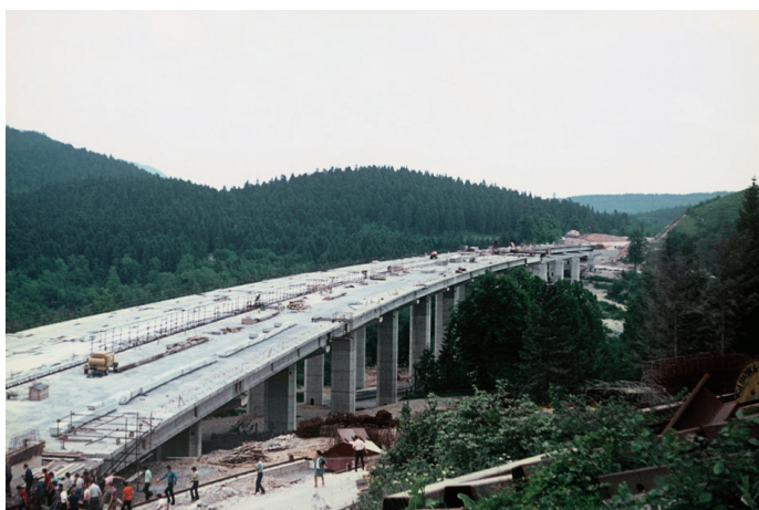
Slika 10. Gradnja viadukta Ravbarkomanda na odseku med Uncem in Postojno. (Vir: Fotoarhiv DARS).
