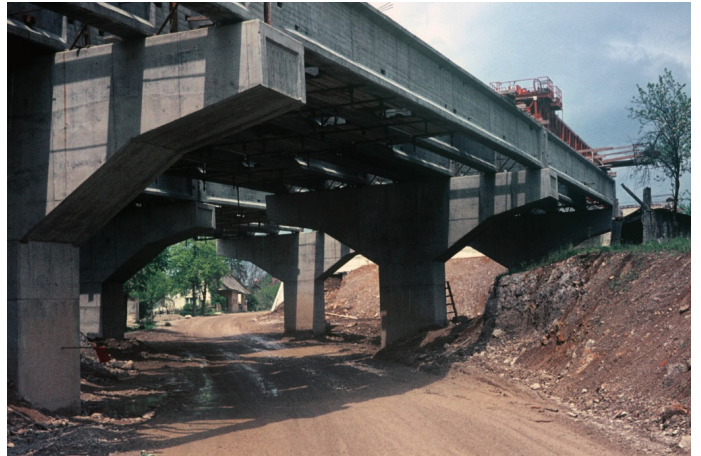
Slika 8. Gradnja viadukta Ivanje selo. (Vir: Fotoarhiv DARS).
