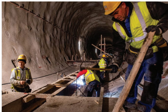
Slika 6. Opažanje centralnega kanala v talnem oboku iz litega betona v predoru Mlinarji (T7).
