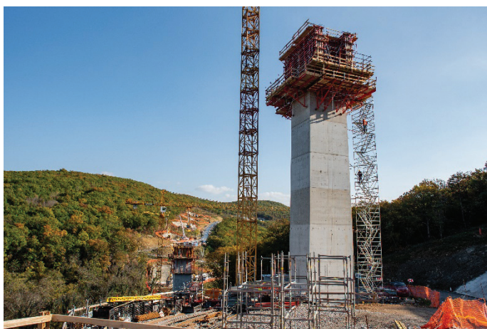
Slika 13. in 14. Segmentna gradnja stebrov viadukta Vinjan.
