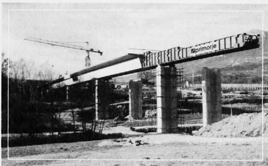
VIADUKT RIBNIK, KI GA PRIMORJE GRADI POD VIPAVSKIM KRIŽEM, JE VSAKIH 14 DNI DALJŠI ZA EN TAKT, TO JE ZA 37,5 METROV.
