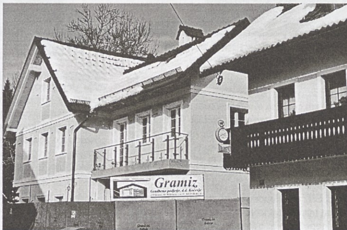
PO MESTU RASTEJO OBNOVLJENE STAVBE, TUDI PO ZASLUGI INOTHERMA
