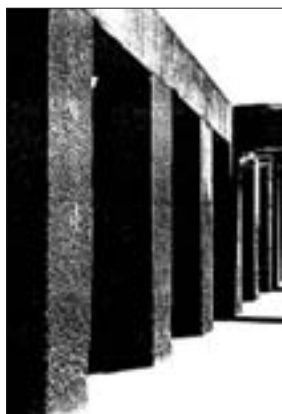
Slika 1: Prikazana zasnova konstrukcije, ki jo sestavljajo obdelani granitni nosilci in stebri vestibula Kefrenovega svetišča v Gizeh, kaže na nujnost obvladovanja znanja o dimenzioniranju gradbenih elementov.
