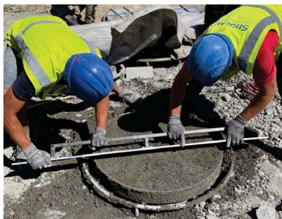
Priprava, ravnanje mikroarmiranega betona v kalupu
