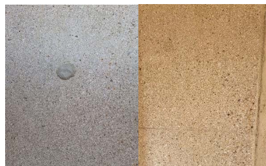
Slika 4: Zapolnjena cev pred in po brušenju
