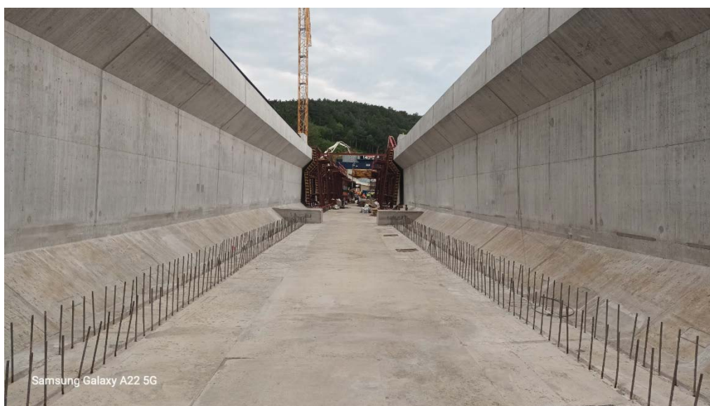
Slika 1: Prekladna konstrukcija viadukta Gabrovica
