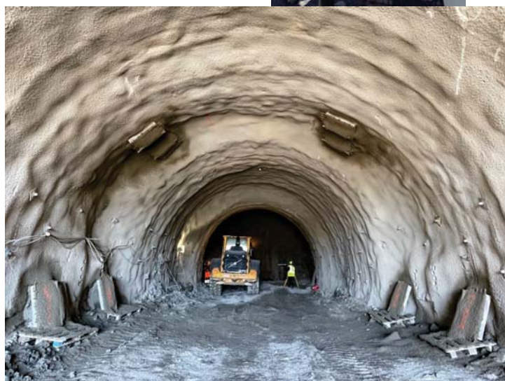
Nabrizgani kalupi na stenah in stropu na sprejemnem preskusu za upravljalce šobe
