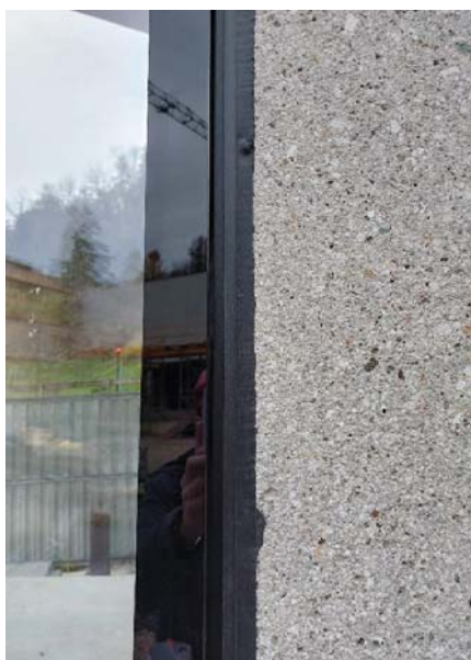
Slika 13: Prikaz zaključka stene brez dvojnega opaža
