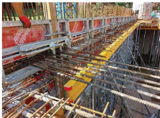
Slika 11: Pripravljen opaž
