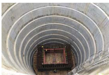
Globoko temeljenje - vodnjaki
