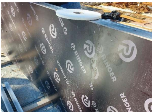
Slika 6: Privijačene vezne plošče
