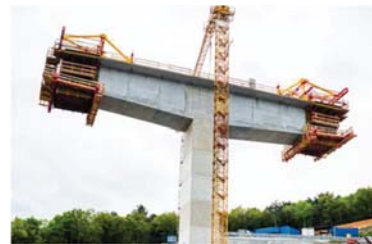
Prosto konzolna gradnja steber 7
