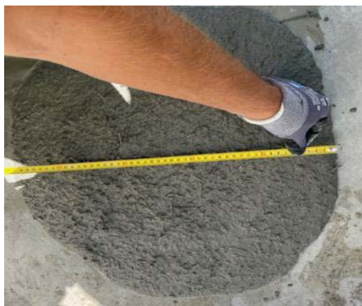
Meritve obdelavnosti sveže betonske mešanice na gradbišču
