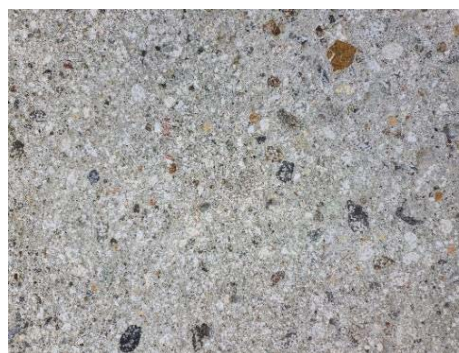
Slika 3: Brušen in štokan vidni beton
