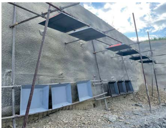
6 kalupov, nameščenih na stropu in 6 kalupov, nameščenih na steni
