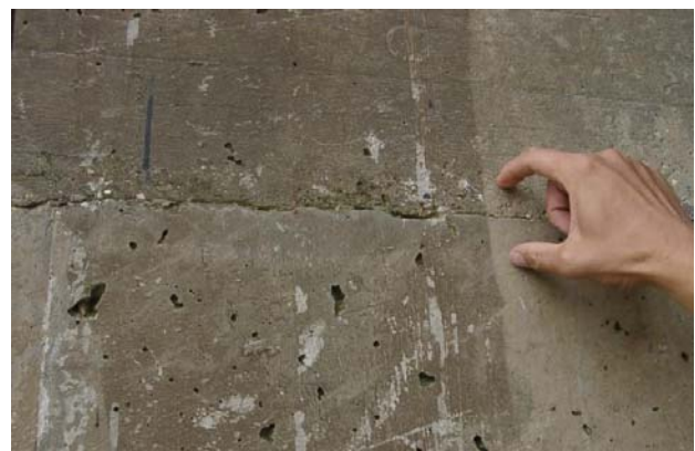
Slika 7: Odprti stik med blokoma jezovne zgradbe HE Vrhovo.
