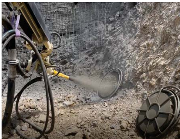
Brizganje mikroarmiranega betona v kalup po ASTM C1550
