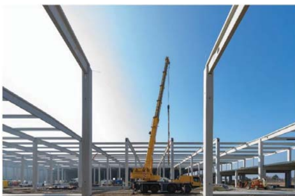
Montaža armiranobetonske konstrukcije
