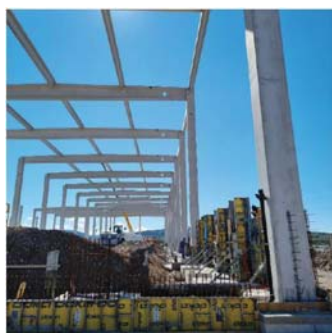
Izvedba parapetnih zidov okoli objekta. Betonaža zunanjih armiranobetonskih plošč.
