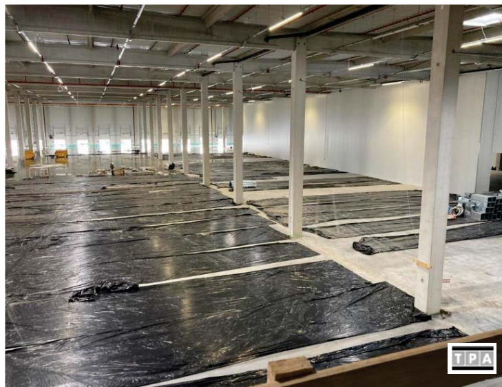
Slika 3: Nega talne MAB plošče s pokrivanje s PVC folijo
