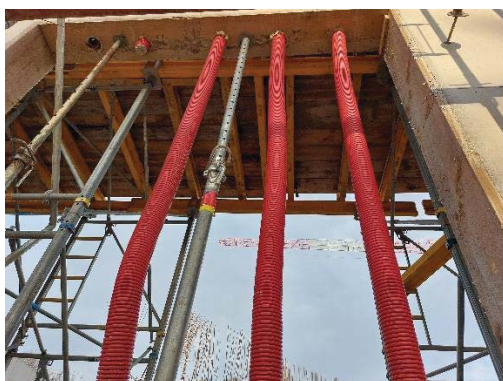
Slika 7: Cevi in postavljen opaž
