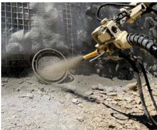
Brizganje mikroarmiranega betona v kalup po ASTM C1550
