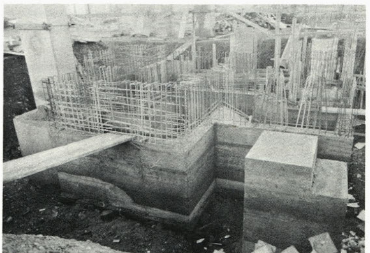
Temelji v novi livarni
