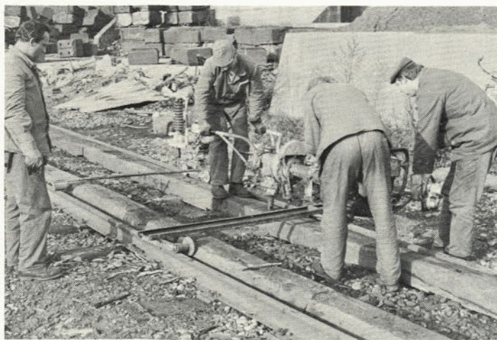
Priprava proge za novo cestišče
