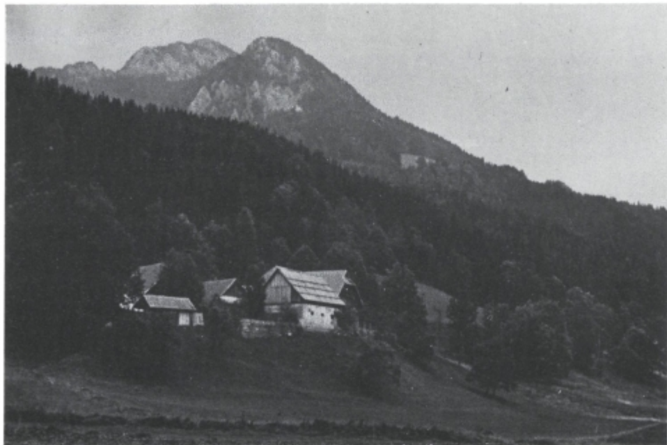
Sl. 15. Tudi dom Robleka na Zgornjem Jezerskem je ohranil še mnoge elemente stare kmečke arhitekture.
