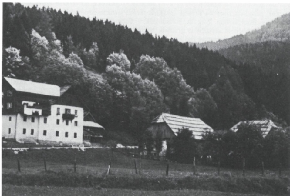
Sl. 1. Štularjeva domačija na Zgornjem Jezerskem je na položnejših tleh severnega obrobja kotlinice. Velika hiša še danes kaže na nekdanjo bogatijo s trgovino in gostilno.
