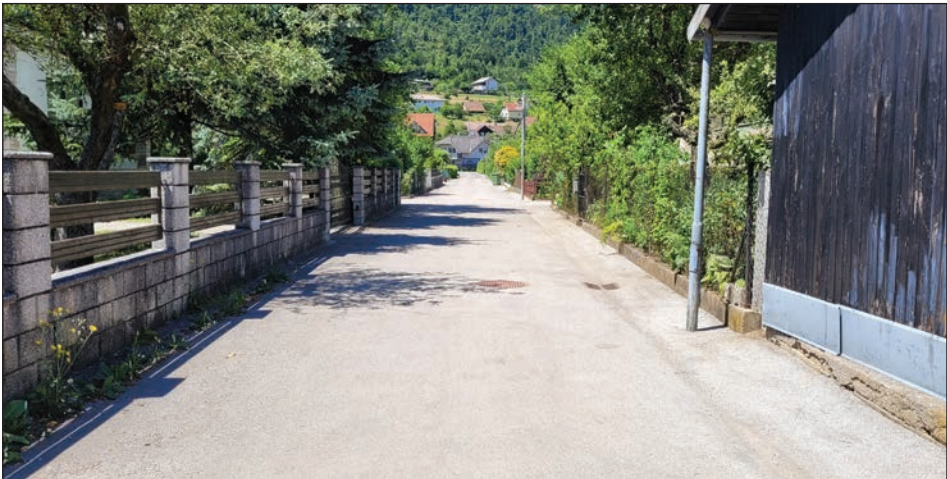
Slika 2: Fotografija prikazuje cesto, ki vodi skozi naselje, ki je bilo zgrajeno na temeljih taborišča. Levo in desno stojijo hiše, na nekaterih so še vidni temelji barak (Foto: Urška Lampe, 2021).
