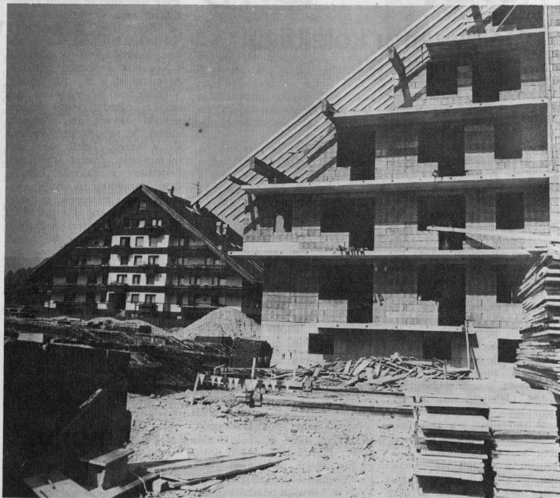
Gradnja stanovanjskih blokov na Jaršah (foto Kraigher)
