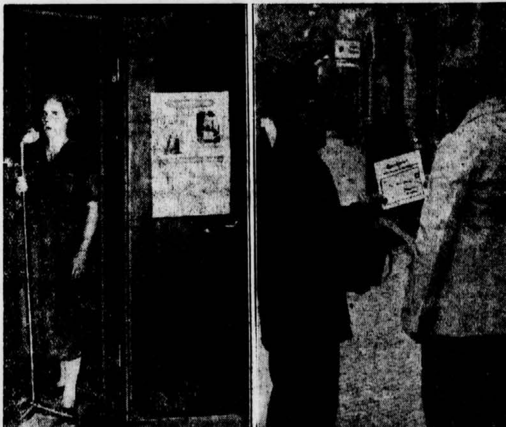
Auf einem Berliner Postamt wurde jetzt der erste Sprechbriefverkehr der Deutschen Reichspost in Betrieb genommen. In einer Telephonzelle spricht man seinen Brief in ein Mikrophon (Bild links) und bespricht damit eine Schallplatte, die dem Empfänger als Brief (Bild rechts) zugestellt wird. Ein »Vierminutenbrief doppel-seitig« besprochen kostet dabei nur 3.75 RM. (Scherl-Bilderdienst-M.)
