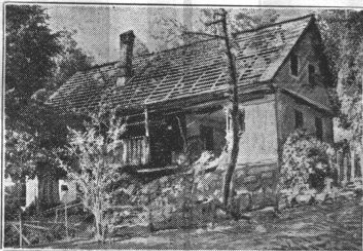
Od povodnji porušena hiša posestnika Noseta ob cesti v Kolenčevi vasi. Slično so prizadeta še razna poslopja v Strugah.
