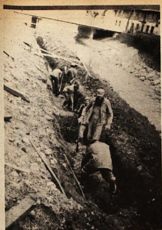
SODRAŽICI KANALIZACIJO – Delavci operarsko-gradbenega podjetja z Mirne na Dolenjskem gradijo kanalizacijo v Sodražici. Skupna dolžina kanalizacije, ki bo zajela vso Sodražico, bo znašala 3 km, na njenem zaključku pa bo še čistilna naprava. Gradnjo financira KS Sodražica. (Foto: Milan Glavonjič)
