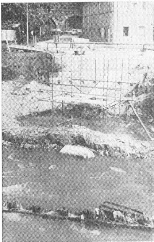
Nov most čez reko Mežo (tako se je začelo)
