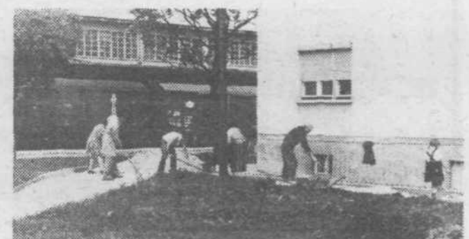
Vevčani so sami odločili za posipavanje gramoza pred stanovanjskim blokom ob Cesti 30, avgusta št. 1. Na delovni akciji so za delo poprijeli skoraj vsi stanovalci. C. ZUPANČIČ
