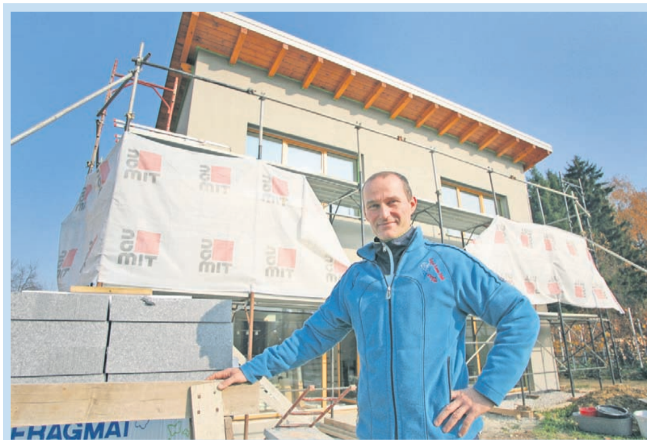
Med našim obiskom so v notranjosti hiše skrbeli še za zadnje podrobnosti, zunanosti pa je manjkala še fasada. Oboje je danes že končano.
