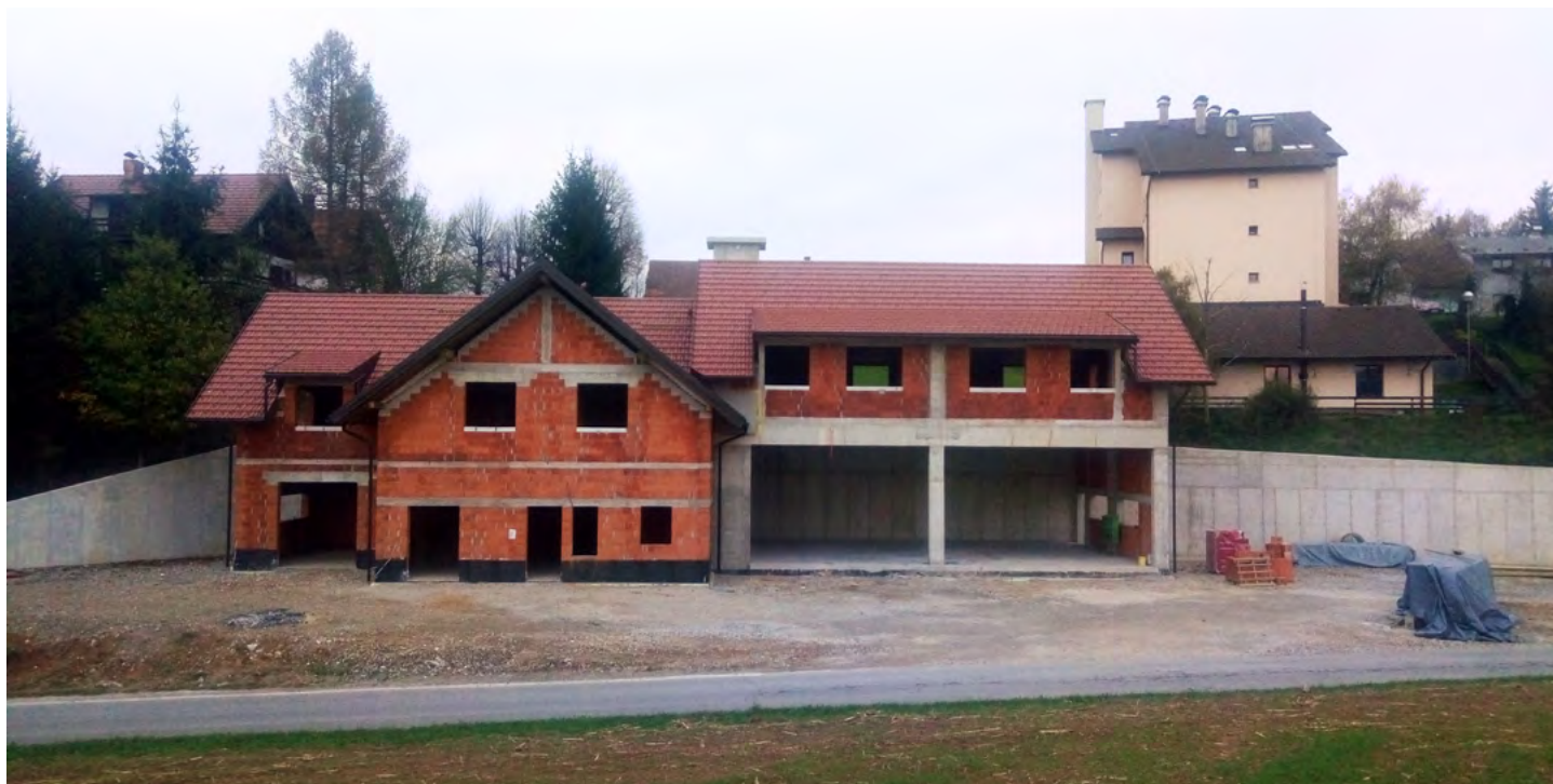
Gasilski dom v gradnji
