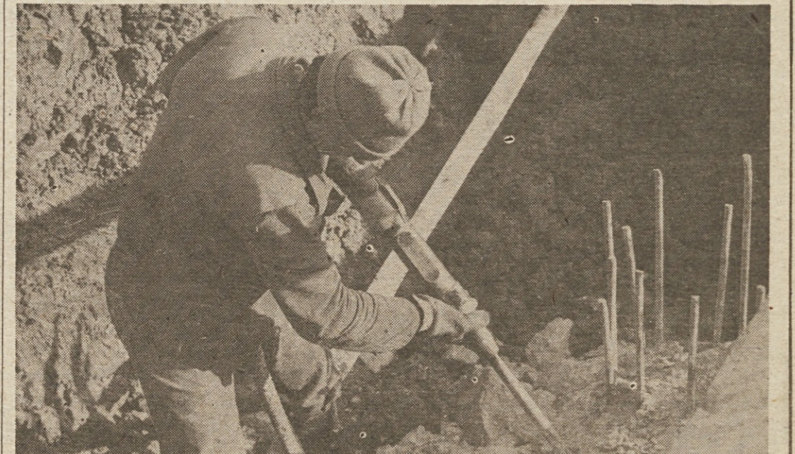
Gradnja »TEO« v Sentjurju
