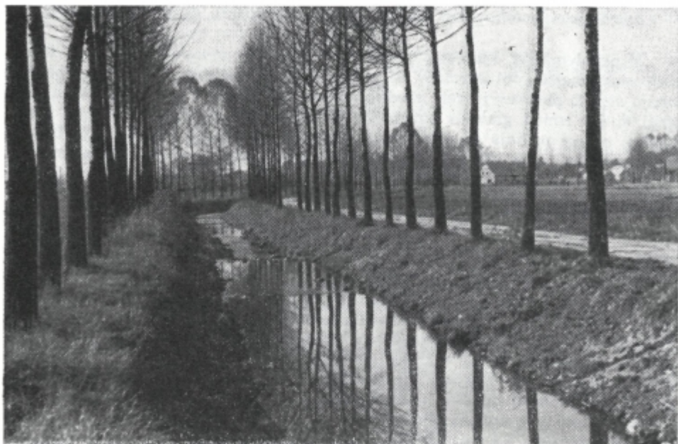
Sl. 6. Z regulacijo so povečali strmec ložniški strugi. Na številnih mestih so zgradili na dnu struge lesene ali kamnite pragove, ki preprečujejo nizkim vodam prenegli odtok, obenem pa vzdržujejo željeno gladino talnice na kmetijskem zemljišču v neposredni bližini Ložnice.
