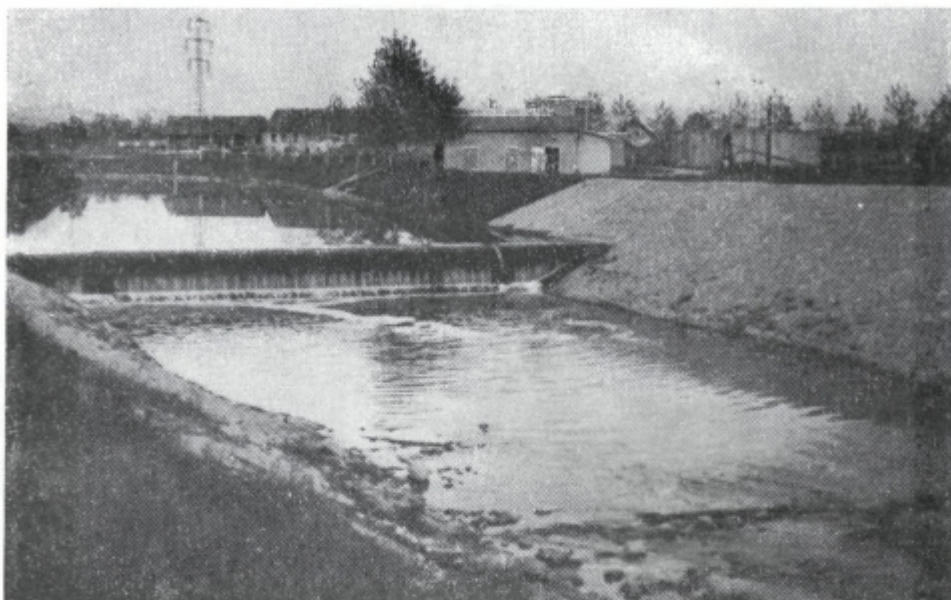
Sl. 10. V letu 1976 so zgradili tik nad ustjem Hudinje v Gaberju tako imenovani »mehki jez«, ki je prvi te vrste pri nas. Njegova konstrukcija namreč preprečuje visoki vodi, ki se nabere v celjski sovodnji, da bi prodirala po hudinjski strugi navzgor.
