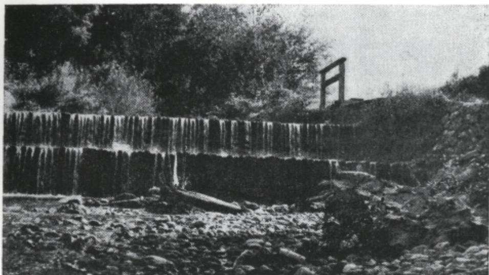
Sl. 21. Pogled na Soržev jez (Polže pri Strmcu), ki stoji na Hudinji. Leta 1925 so zgradili betonski jez, ki ga je odnesla septembrska povodenj 1964. leta. Nato so skupno z Vodno skupnostjo iz Celja postavili lesen jez. Voda je poganjala Soržev mlin do 1953. leta, žago do 1974. leta, ko opustijo obrt ter turbino za dinamo, sadni mlin, cirkularko in kovačnico.
