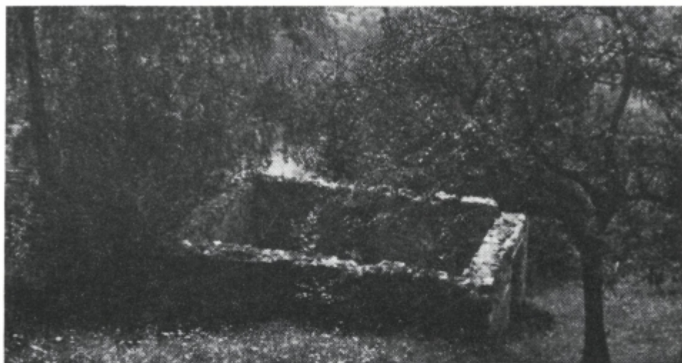
Sl. 27. Stebleški potok, ki je desni povirni krak Trnovščice, je poganjal 13 mlinov, a danes le še Lipškega. Kokečev — Blazniškov mlin je bil eden izmed redkih, ki je imel dva gospodarja. Po zadnji vojni so pogon preuredili na turbino; mlin pa opustili po letu 1960.
