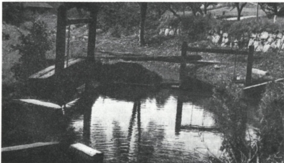
Sl. 18. Tik pod izvirom Toplice (v Verpetah) stoji Jerebov leseni jez na Tésnici. Od tu dalje teče voda po 60 m dolgi mlinščici do Jerebovega doma, kjer sta mlin in žaga.
