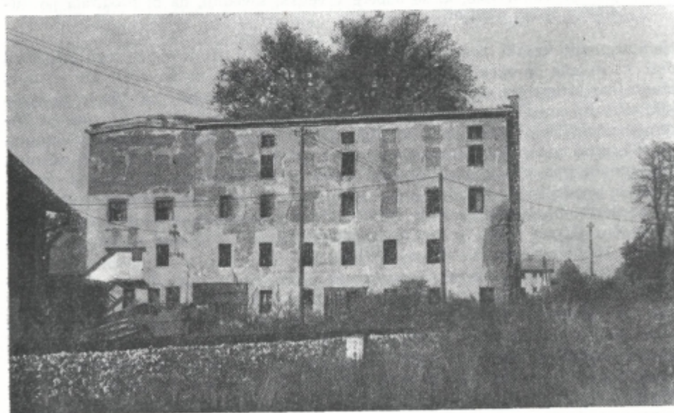
Sl. 12. Poslopje nekdanjega velikega industrijskega valjčnega mlina, katerega lastnik je postal Peter Majdič iz Kranja leta 1888. Stoji na desnem bregu Hudinje na Spodnji Hudinji. Danes je v stavbi le še skladišče za žito, ki ga predeluje Merxov električni mlin.
