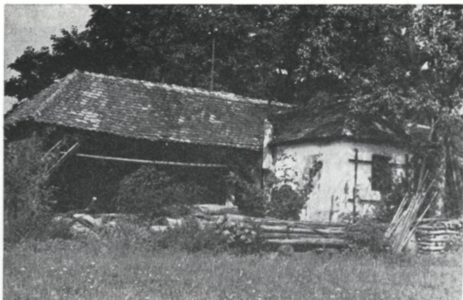
Sl. 26. Sorževa žaga na Hudinji v Polžah pri Strmcu je ena izmed zadnjih, ki občasno še dela za domače potrebe. Poganja jo vodno kolo na lopate. Vse do leta 1974 so imeli pri Sorževih tudi žagarsko obrt.
