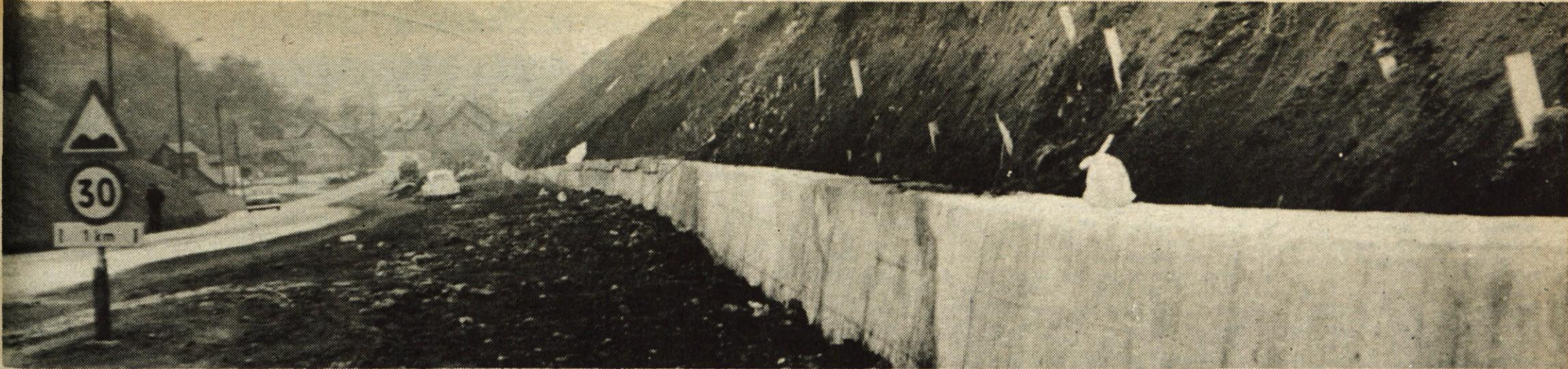
Železarna Jesenice se je odločila, da uredi nasip ob magistralni cesti na Jesenicah. Dela opravljajo delavci jeseniškega Kovinarja, in sicer bodo zgradili betonski zid stopničaste oblike in bo tako okolica Železarnе, kjer odlagajo odpadni material, lepše urejena. (ds) — Foto: D. Dolenc
