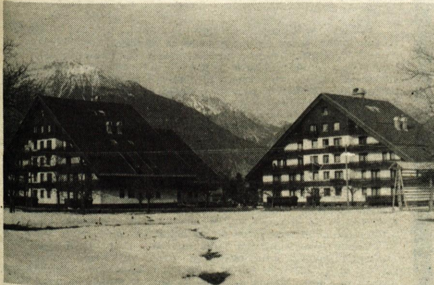
Na problemski konferenci v Radovljici so v četrtek, 25. marca, precej govorili tudi o gradnji družbenih stanovanj na Jaršah na Bledu. Sklenili so, da se bodo ta ali najkasneje prihodnji teden na Bledu sestali vsi zainteresirani in se pogovorili o gradnji družbenih stanovanj na Bledu. Na sliki: Prvi stanovanjski objekti na Jaršah, kjer je po zazidalnem načrtu predvidenih še več takšnih stanovanj. Vendar v krajevni skupnosti menijo, da je z gradnjo treba počakati do novelacije urbanističnega načrta. — A. Zalar
