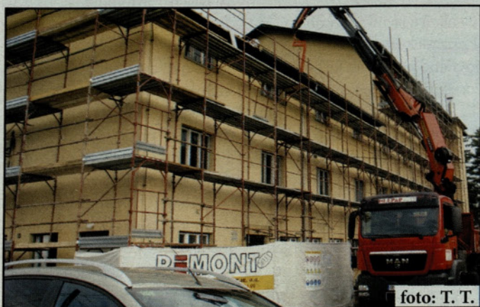
Obnova stare sušilnice v Žalcu
