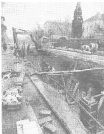
Takole Kanalizacija koplje jarek za novo kanalizacijo na Mirju.
