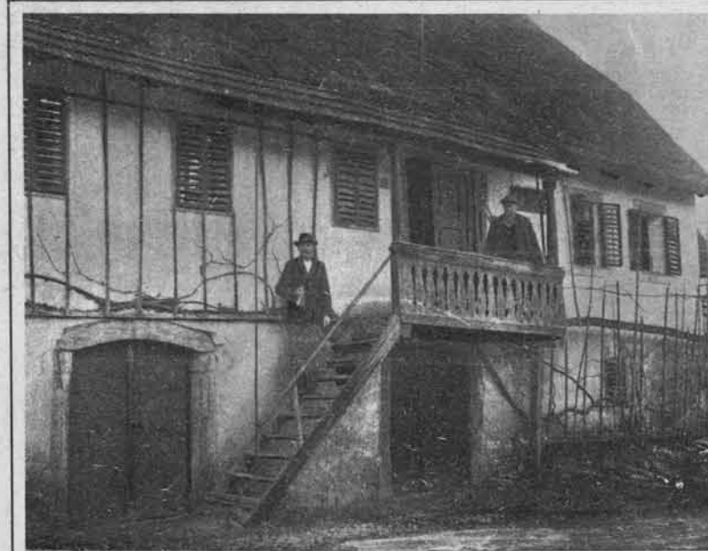
Tipična slovenska hiša z Dolenjske, ki ima v pritličju kleti, v prvem nadstropju pa stanovanjske prostore.
