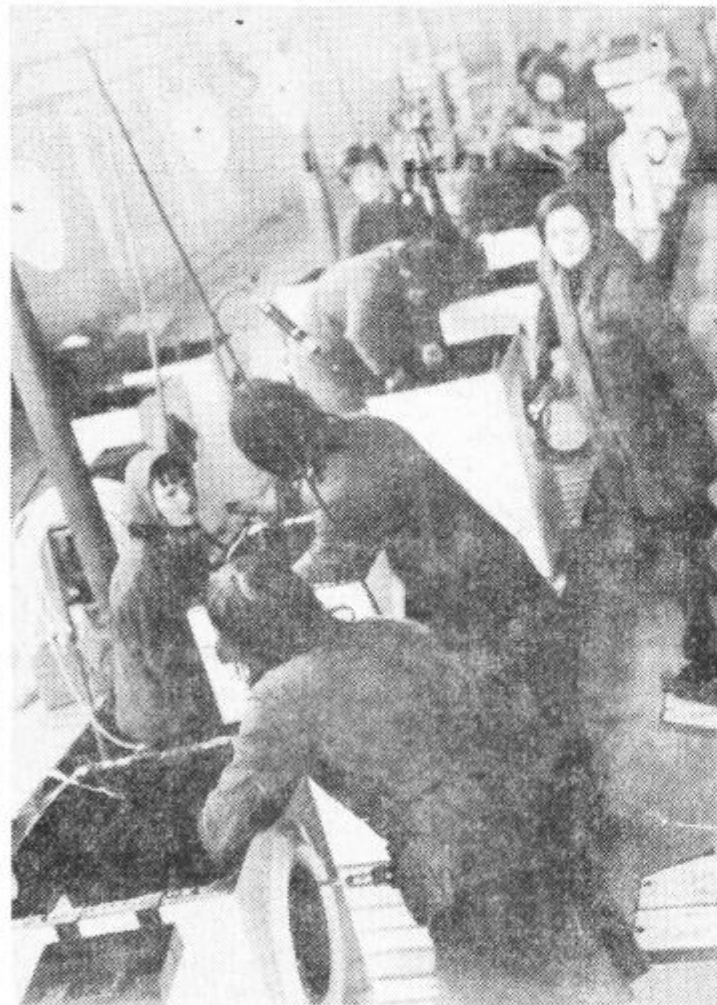
Montaža superavtomatskih pralnih strojev
