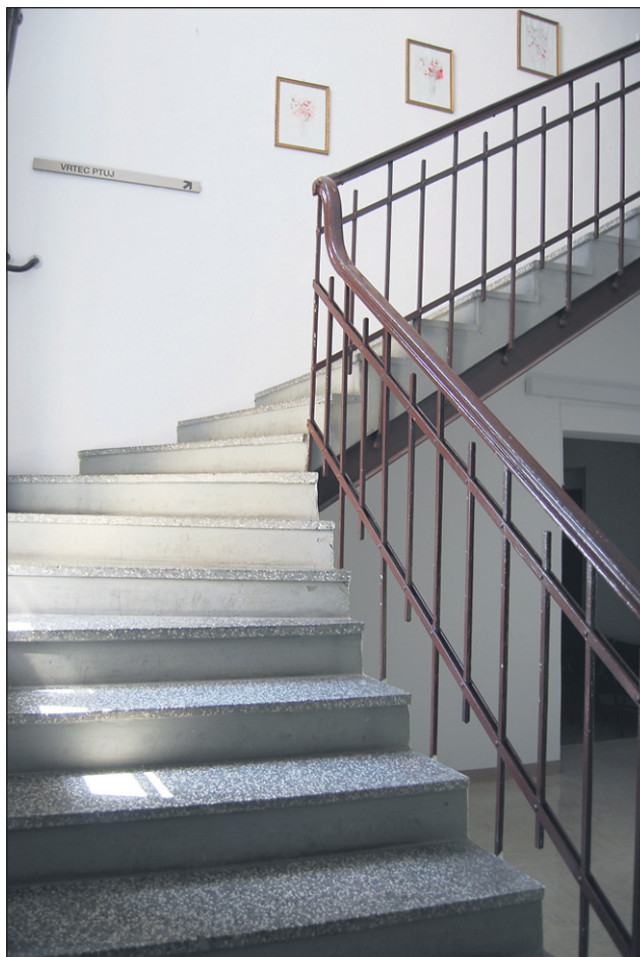
Do prostorov uprave Vrtca je 79 stopnic.
