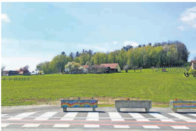
Razlastitveni postopek je še vedno v teku. V tem primeru gre za dve cesti in dva problema, eno obstoječo in drugo, ki jo šele nameravajo graditi.
