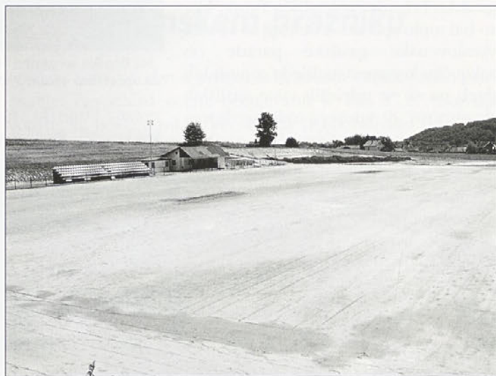
Pogled na gradbišče, kjer nastaja povsem novo, razširjeno športno igrišče
